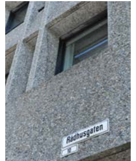
Det nye rådhuset i Bergen: Erling Viksjø tegnet rådhuskomplekset allerede i 1953 i forbindelse med at han vant arkitektkonkurransen, men rådhusblokken sto ikke ferdig før i 1971. Som mange av Viksjøs byggverk, og som det første i Bergen, ble rådhuset reist i naturbetong.
