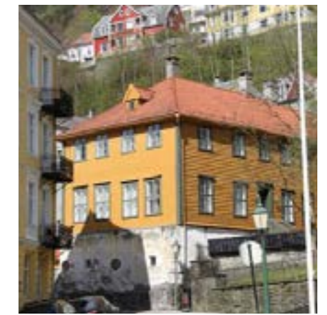
Latinskolen, i dag Bergen skolemuseum, ble oppført etter tegninger av Hans Martin Heintz og tatt i bruk i 1706. Skolen er en av de få trebygninger med utmurt bindingsverk i Bergen.
