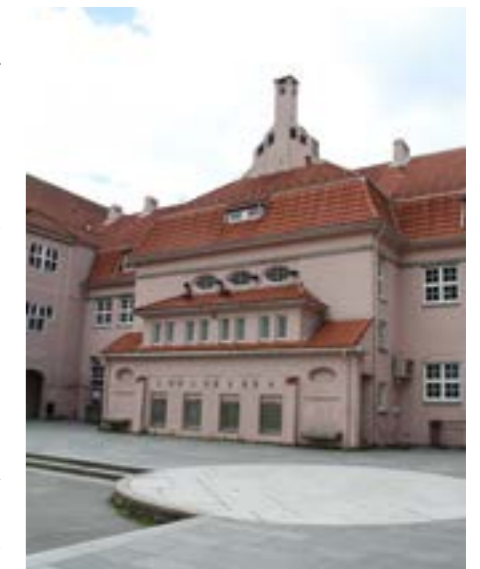
Rothaugen skole, det første skoleanlegget som byarkitekt Kaspar Hassel tegnet (1912) Rothaugen er et godt og representativt skoleanlegg fra 1910-årene som viser overgangsfasen mellom jugendstil og nybarokk.
