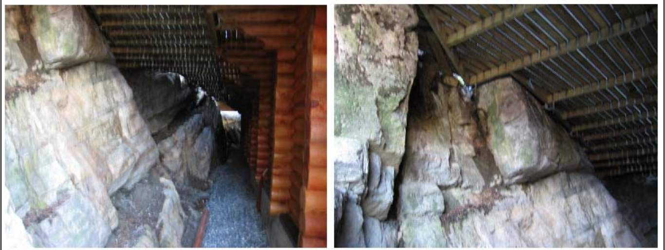
Figur 8. Bilder som viser forholdene under terrasse til Øvre Kråkenes 66. Bildet til høyre viser mulig labil blokk.
