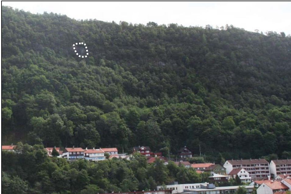
Figur 8: Fjellsiden over Kolstien 25 – 33. Kildeområdet for skredet 25/12-98 er markert.
