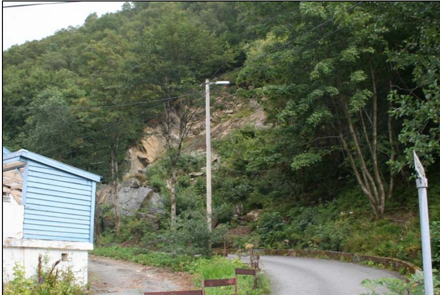
Figur 11: Skredmasser ved Kolstien 77
