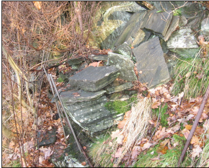
Figur 5 Nedsatte stag i bergmasse.
