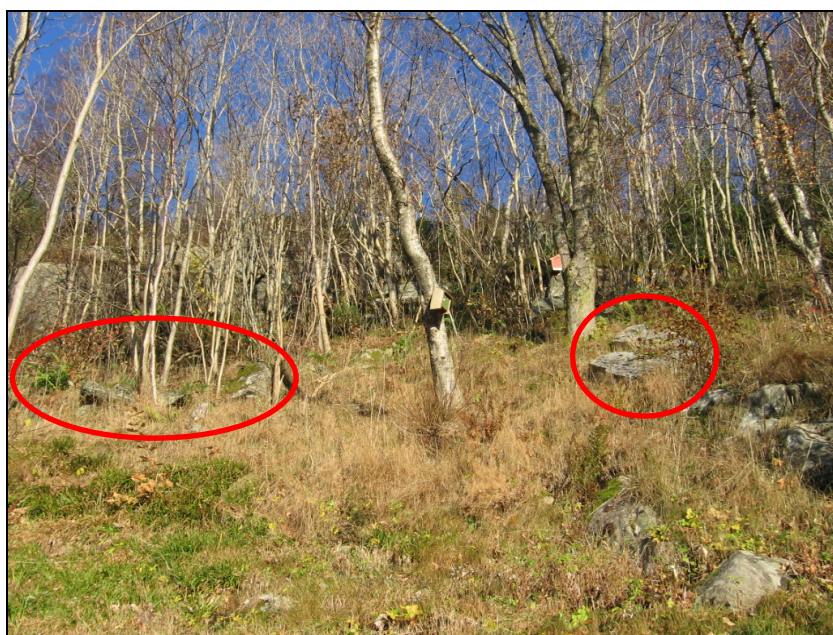
Figur 2 Eksempel på løse blokker i terreng over Salhusvegen 103.
