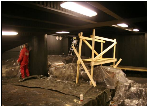
Figur 42. Under arbeidet ble hele ruinen dekket med plast og en mobil rampe ble bygget for å unngå tråkk på murkronene (foto: Byantikvaren).
