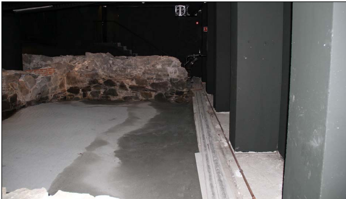
Figur 37. Tregulvet fra middelalder ble dekket med fuktsperre og grus. Den fuktige undergrunnen vises av det mørke feltet i grusedekket langs vestveggen i ruinrommet (foto: Byantikvaren).
