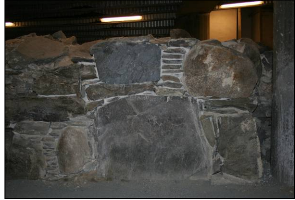
Figur 28. Etter: Rekonstruert parti i 2009. Det ble benyttet kalkmørtel og murene ble forsøkt rekonstruert i harmoni med det øvrige murverket i ruinen (foto: Byantikvaren).
