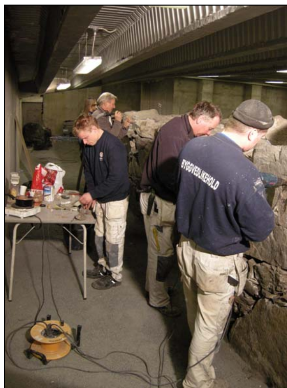
Figur 23. Reparasjon på ytre vegg liv mot sør. Fra venstre; Tor Arne Birkeland, Geir Magnussen, Arvid Grindheim, Kjell Kaalaas og Kenneth Rasmusen.
