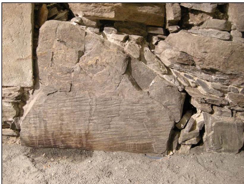
Figur 25. Samme stein etter at den er reparert med lim (foto: Byantikvaren).
