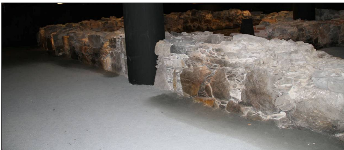
Figur 49. Langs murene hvor det ikke er lagt fuktsperre kan en tydelig se fuktutslag i grusen. Fuktsperren er utelatt her for å begrense at fukt fra undergrunnen slår inn i murverket (foto: Byantikvaren).
