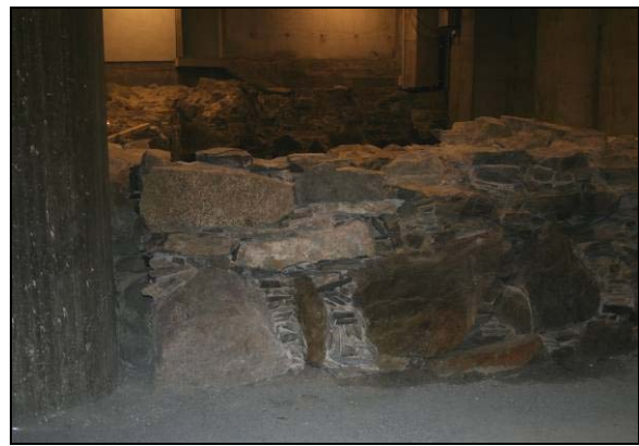
Figur 30. Etter: Rekonstruert i 2009 ved nordre støttesøyle, ytre murliv (foto: Byantikvaren).
