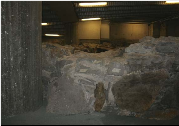
Figur 29. Før: Rekonstruert parti fra 1983 ved nordre støttesøyle, ytre murliv (foto: Byantikvaren).
