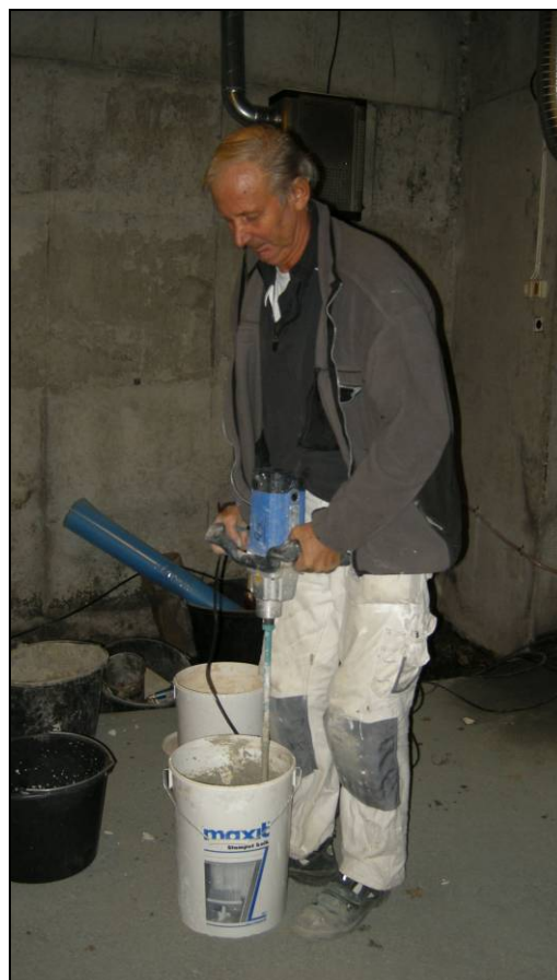
Figur 14. Arvid Grindheim blander kalkmørtel med en elektrisk mørtelvisp (foto: Byantikvaren)
