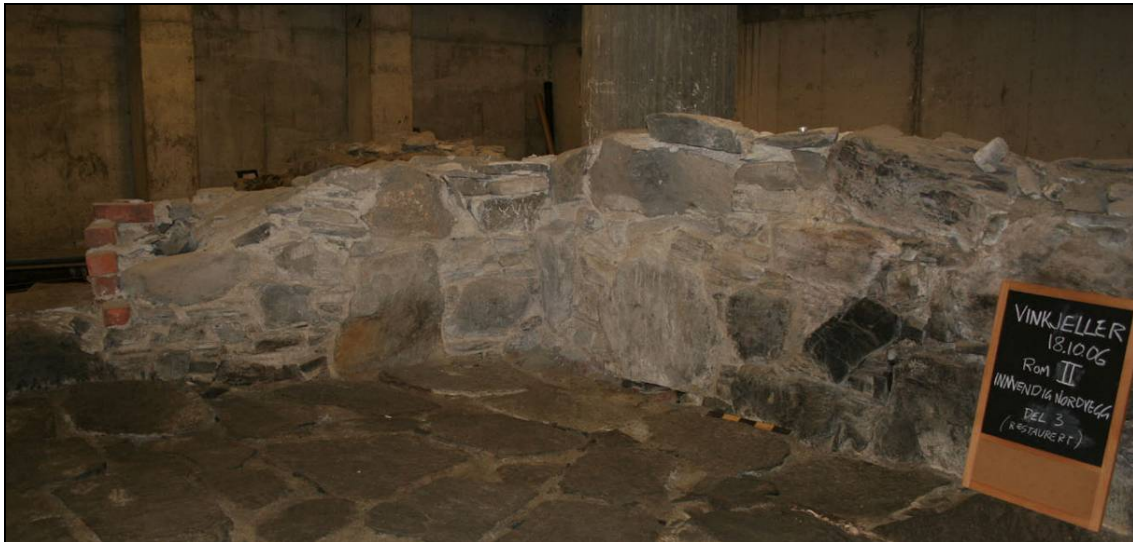
Figur 33. Før inngrep: indre murliv ved nordlig støttesøyle før det ble tatt ned og rekonstruert (foto: Byantikvaren).
