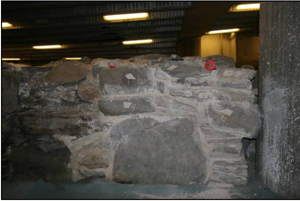
Figur 27. Før: Rekonstruert parti fra 1983 ved nordre støttesøyle, ytre murliv. Det var benyttet sement og rekonstruksjonen bar preg av hastverksarbeid. Partiet ble tatt ned (foto: Byantikvaren).
