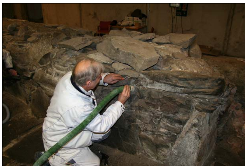
Figur 12. Arve Grindheim renser murverket med maskinstøvsuger (foto: Byantikvaren).
