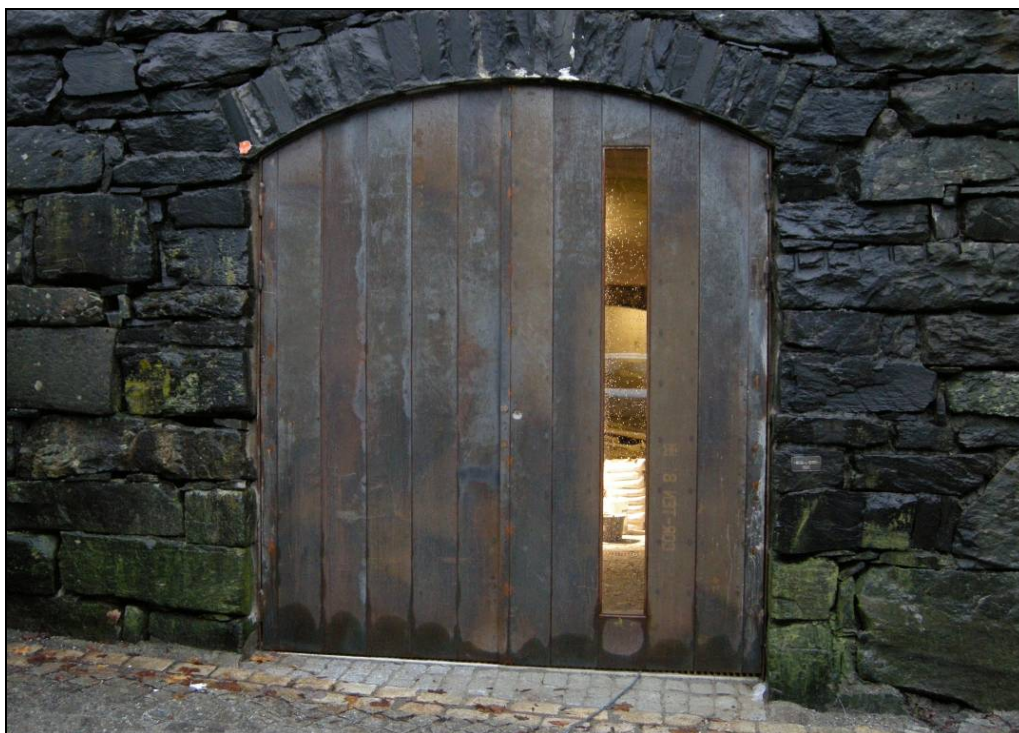
Figur 48. Ny dør sett fra utsiden (foto: Byantikvaren).
