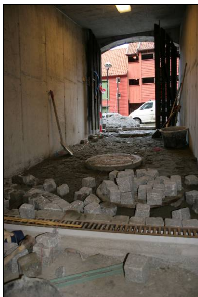
Figur 46. Brostein ble lagt og nye kumløkk i støpejern montert (foto: Byantikvaren).
