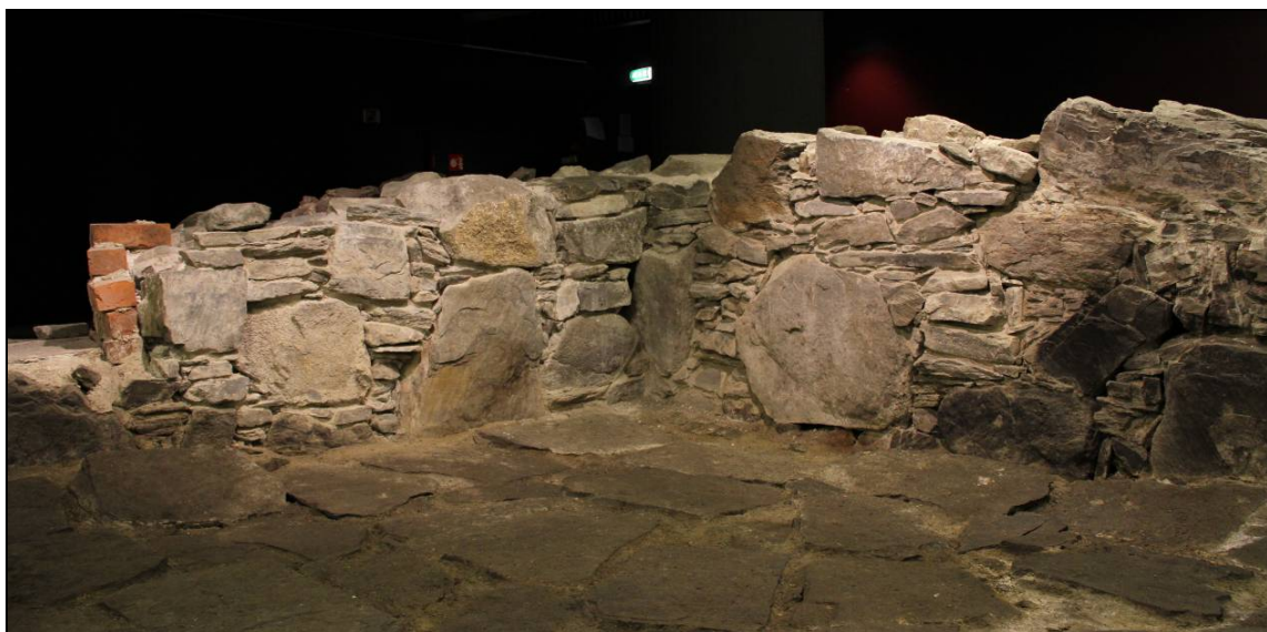
Figur 34. Etter inngrep: indre murliv ved nordlig støttesøyle etter at det er rekonstruert (foto: Byantikvaren).
