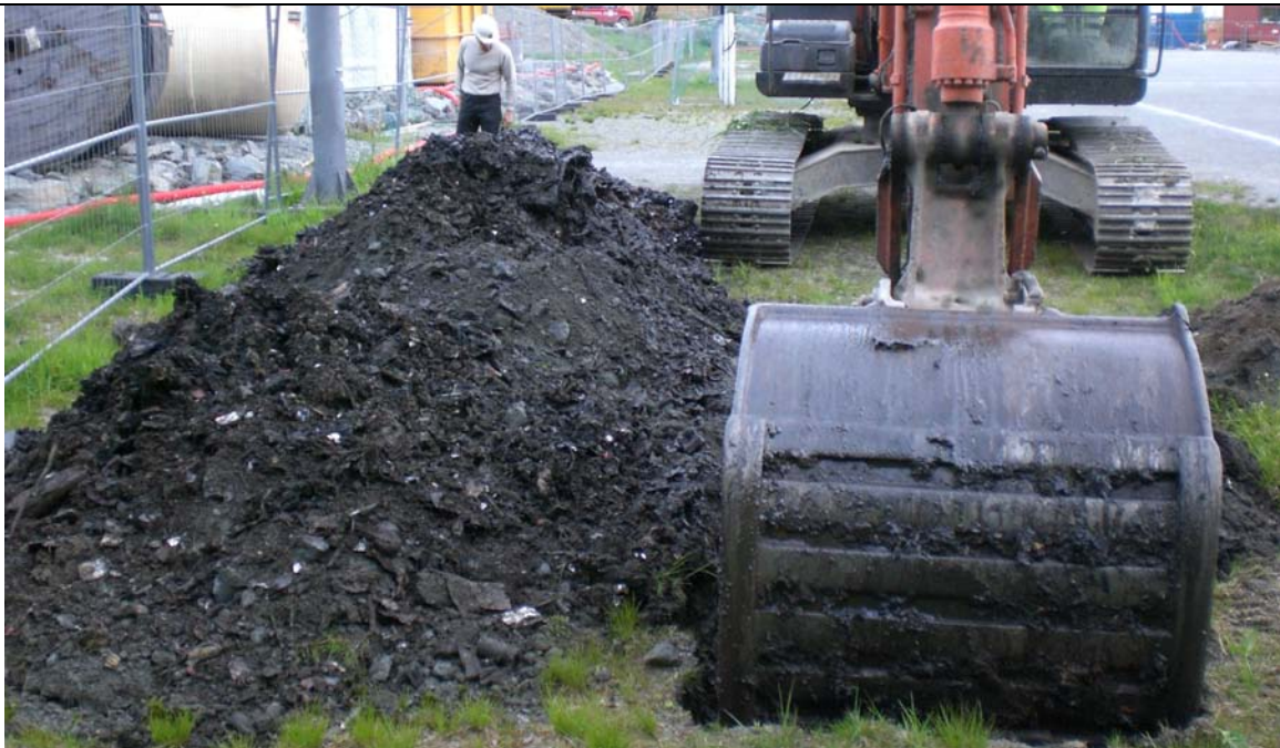
Foto 1-2. Sjakt 1. Oppgravde avfallsmasser har god struktur, og flyter lite utover. De er altså mulig å transportere.
