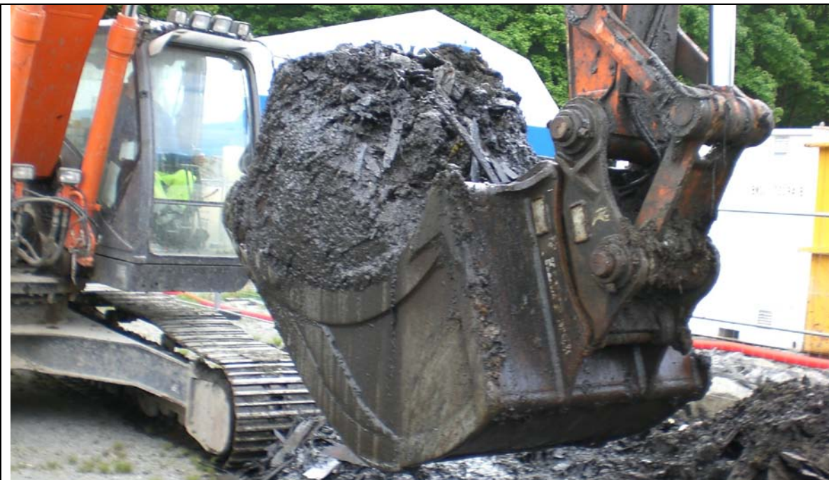
Foto 2-2. Sjakt 2. Oppgravde avfallsmasser har en viss struktur, og flyter lite utover. De er altså mulig å transportere.
