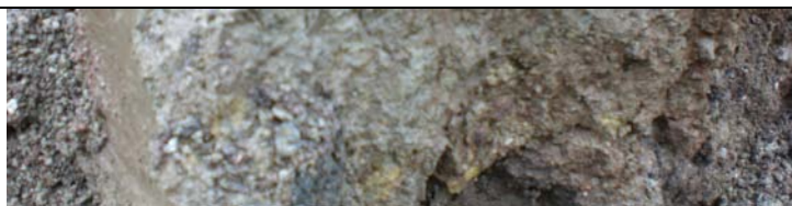
Foto 8-4. Sjakt 8. Leire mellom avfall og fjell. Ca. 0.5 meter tykt lag.
