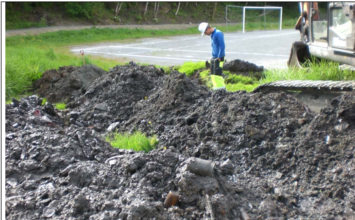
Foto 3-2. Sjakt 3. Oppgravde avfallsmasser har en viss struktur, men de flyter noe utover. De er mulig å transportere.
