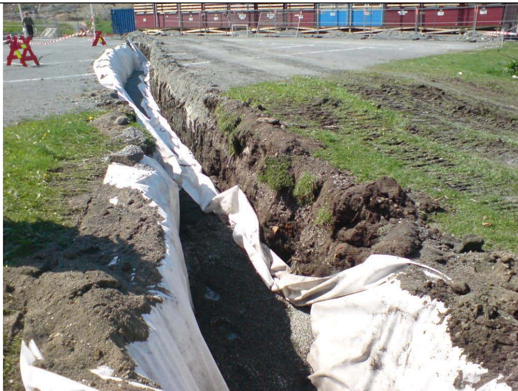
Foto fra kabeltrase
