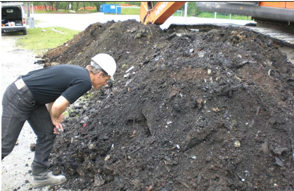
Foto 6-2. Sjakt 6. Oppgravde avfallsmasser er nokså tørre.
