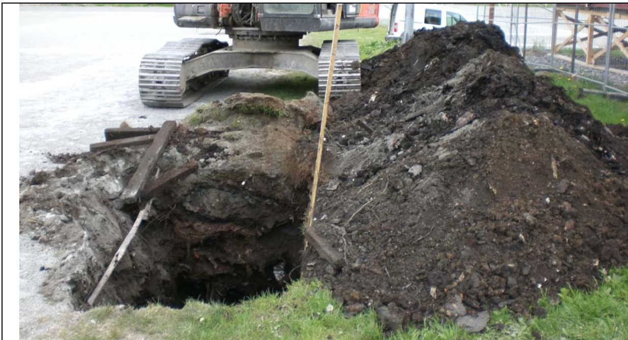
Foto 8-2. Sjakt 8. Oppgravde avfallsmasser er tørre og lett å handtere.
