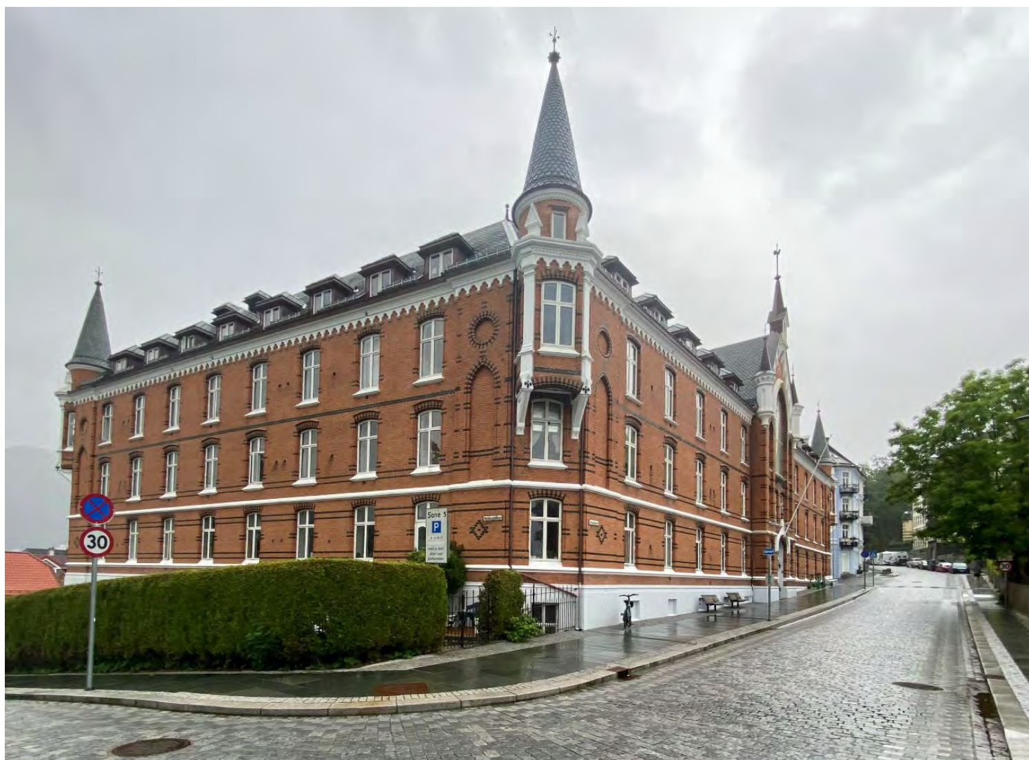
Figur 49: Sjøfarendes aldershjem sett fra nordvest, dvs. fra Nordnesparken. Dette er et praktbygg i ny-gotisk stil tegnet av arkitekt Schak Bull i 1897. Foto: Byantikvaren 2022
