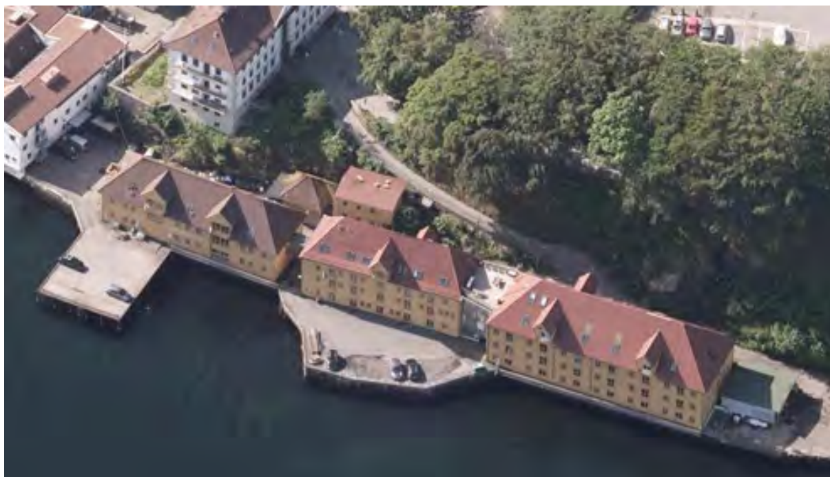
Figur 15: Nordnesbodene 3-5 sett fra nord. De tre bygningene er i dag sammenkoblet og ombygget til kontorformål. Eier av bodene O. Bratland A/S, tidligere funksjoner er bl.a. kjølelager, sildesalteri og kortevare-forretning. Bygningene med bruksareal 4 760 m 2 er i dag utleid til Havforskningsinstituttet. Flyfoto 24.07.2019, gjengitt med tillatelse fra © 2021 Blom.
