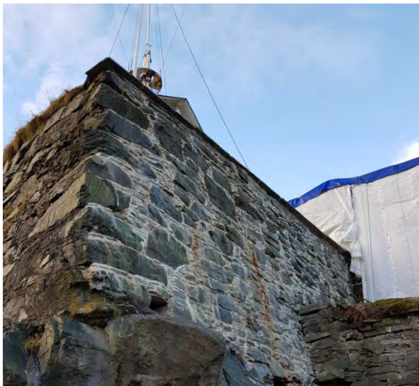
Figur 63-64: Når festningsmurer restaureres etter antikvariske prinsipper, erstattes sement (som har vært benyttet ved tidligere vedlikehold) med kalkmørtel. På bildet til venstre ser vi skillet mellom murverk med lyse fuger (ny kalkmørtel) og sement. Gammel sement og løsmasser fjernes, og de nye fugene bygges opp med pinningsstein og ny kalkmørtel. Arbeidet er krevende i vårt fuktige og kjølige klima og må derfor foregå under tildekkede (i vintersesongen også isolerte) stillaser (t.h.). Foto: Byantikvaren 2017
