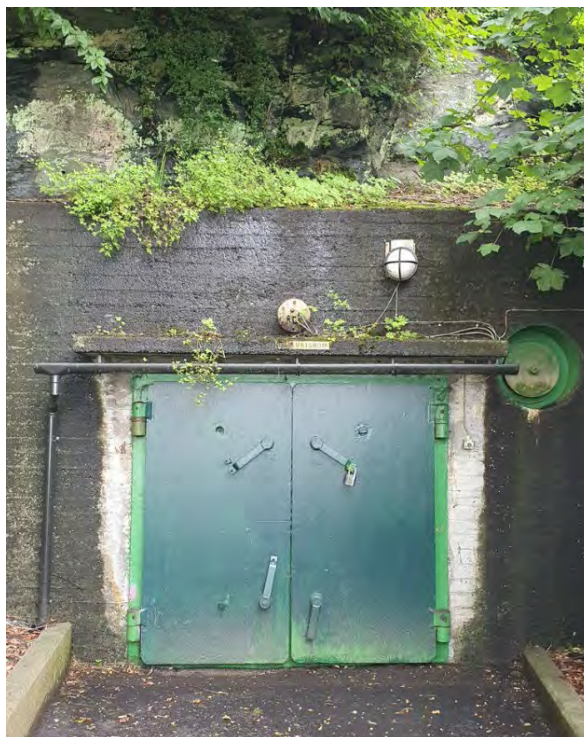
Figur 70: Inngangen til bunkeren for hovedkvarteret til Marine Flak Regiment Bergen som stod tilnærmet ferdig i mai 1945. Foto: Byantikvaren, 2022
