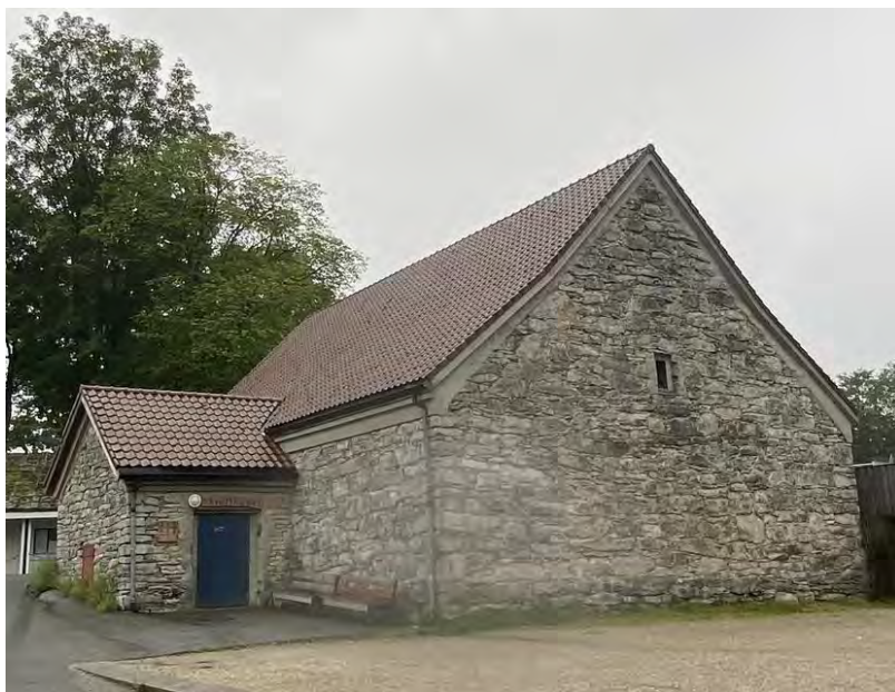
Figur 57: Krutthuset sett fra nordøst. Bygget ble påbegynt i 1814 og ferdigstilt i 1840. Foto: Byantikvaren 2022
