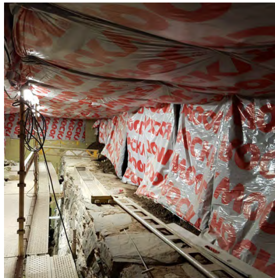
Figur 63-64: Når festningsmurer restaureres etter antikvariske prinsipper, erstattes sement (som har vært benyttet ved tidligere vedlikehold) med kalkmørtel. På bildet til venstre ser vi skillet mellom murverk med lyse fuger (ny kalkmørtel) og sement. Gammel sement og løsmasser fjernes, og de nye fugene bygges opp med pinningsstein og ny kalkmørtel. Arbeidet er krevende i vårt fuktige og kjølige klima og må derfor foregå under tildekkede (i vintersesongen også isolerte) stillaser (t.h.). Foto: Byantikvaren 2017
