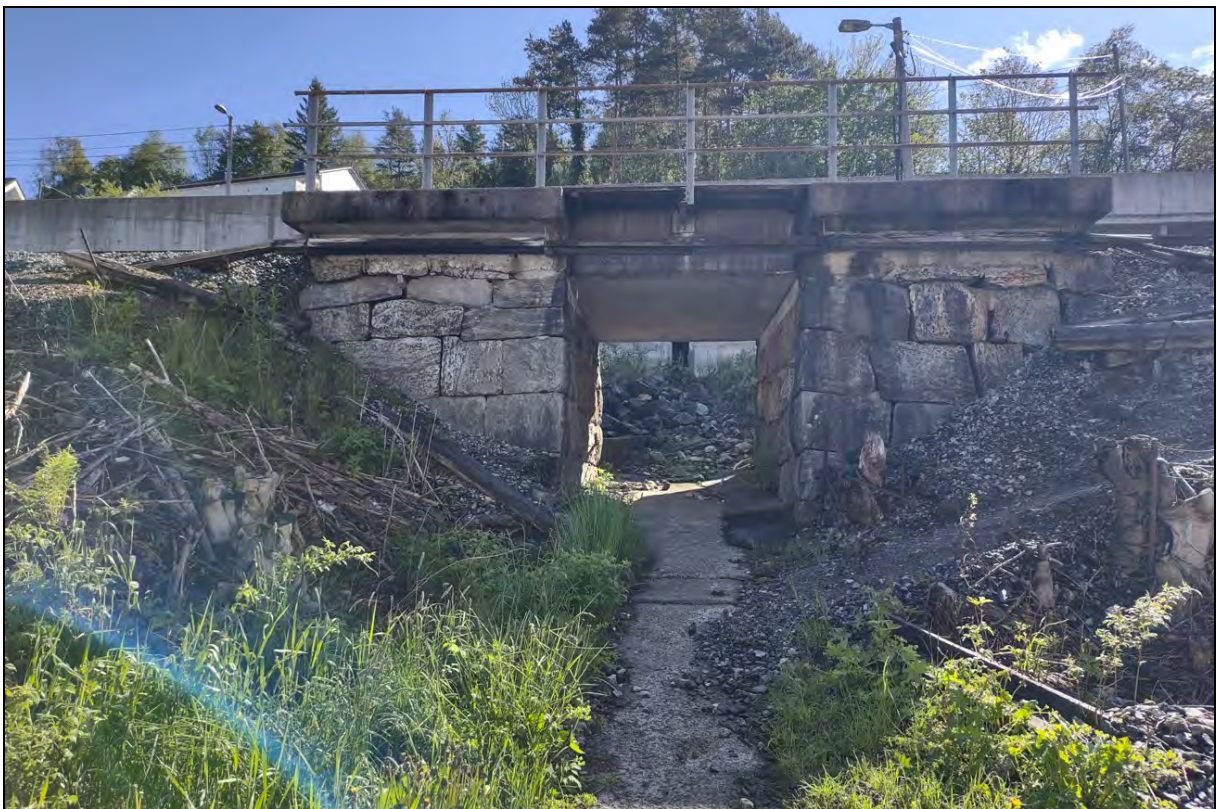
Figur 7: Undergang ved Gamle Vossabanen, som i dag ikke er tilrettelagt for gjennomgang mellom Storaneset og Garnesvegen. Undergangen er avbildet på historisk foto på figur 8 (Foto: Byantikvaren 2022).
