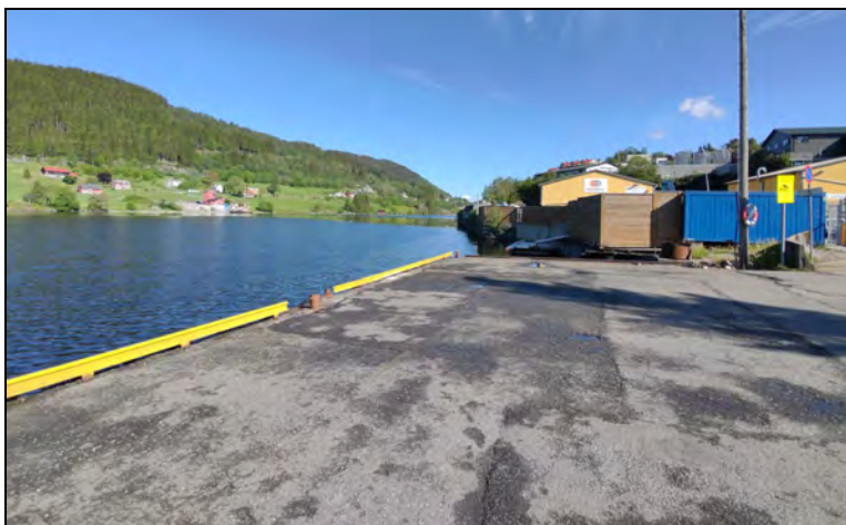
Figur 4: Seimskaien på Storaneset fotografert mot Garnes (Foto: Byantikvaren 2022).
