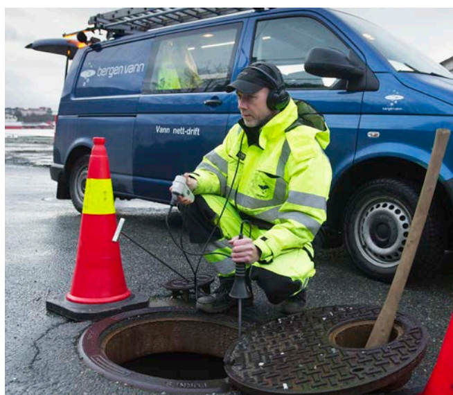
På jakt etter vannlekkasjer. (Foto, Helge Skodvin)
