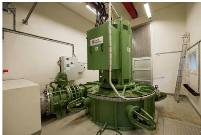
Før vannet går til behandling på Espeland vannbehandlingsanlegg blir det produsert strøm som benyttes på anlegget. (Foto, Helge Skodvin)
