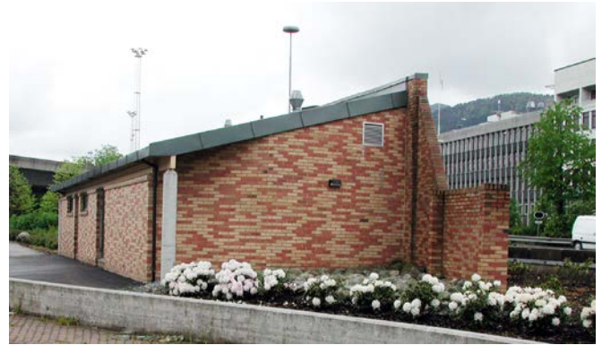
Avløpspumpestasjonen på Nygårdstangen pumper avløpsvann fra sentrum til behandling på Holen avløpsrenseanlegg. (Foto, Berit Gjesdahl)
