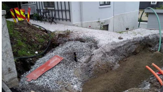
Fornyning og tilknytning av privat nett i forbindelse med opparbeiding av Ibsens gate. (Foto, Einar Høgmo)
