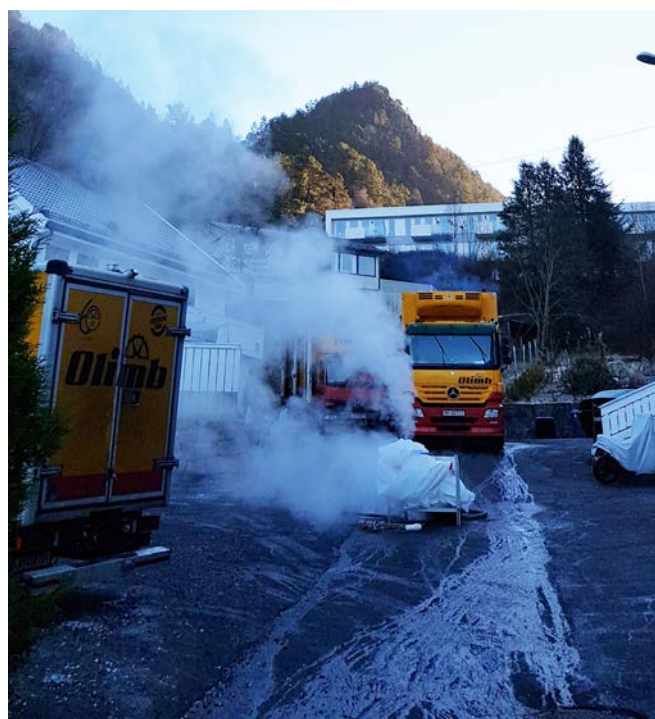
Vann- og avløpsetaten tilstreber å benytte NoDig-metode mest mulig ved fornying av avløpsnett. Her er det herding av strømpen som pågår. (Foto, Gunn Eklund Breisnes)
