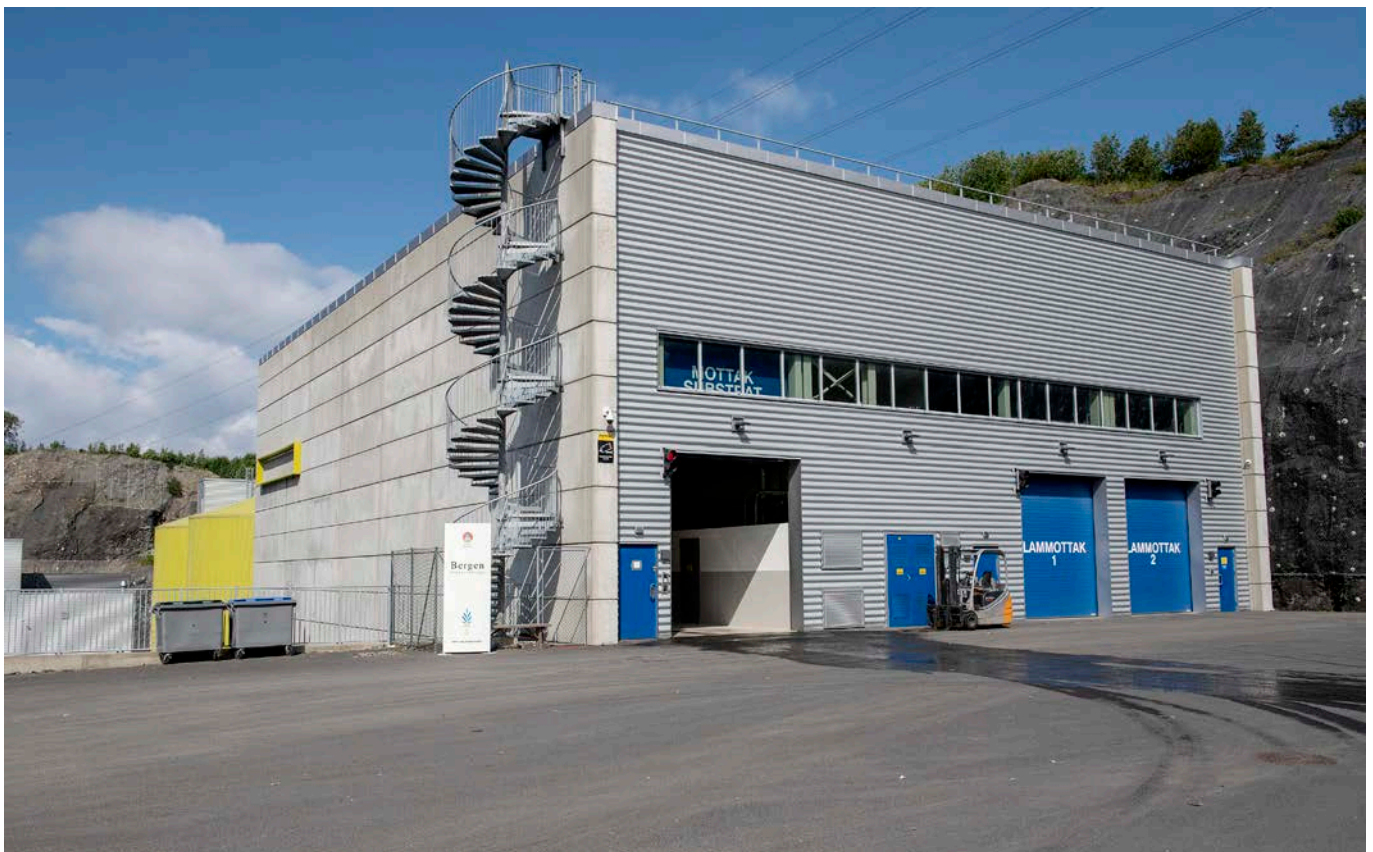
Mottakshallen på biogassanlegget i Rådalen. Hit kommer slam fra renseanleggene, septikk, fett og annet som kan benyttes til produksjonen av biogass. Ved full drift blir det produsert nok biogass til å drifte 80 busser. (Foto, Helge Skodvin)
