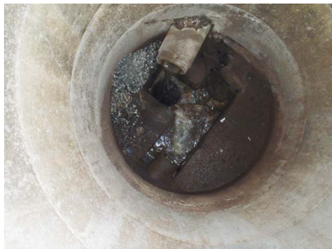
For å hindre oljeforurensning som vist på bildet inn på kommunalt nett, skal alle bedrifter som har olje i avløpsvannet ha oljeutskiller. (Foto, Geir Gjostein)
