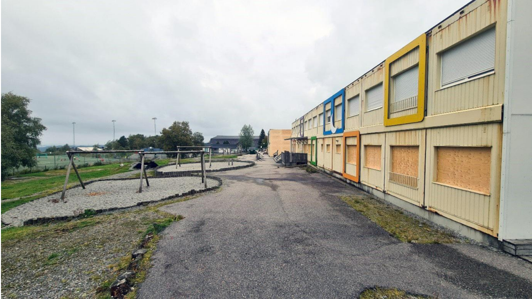
Riving av dette midlertidige barnehagebygget og oppføring av ny barnehage i Olsvik blir eit av pilotprosjekta for utsleppsfrie byggeplassar i Bergen. Foto; Henrik Ravndal
