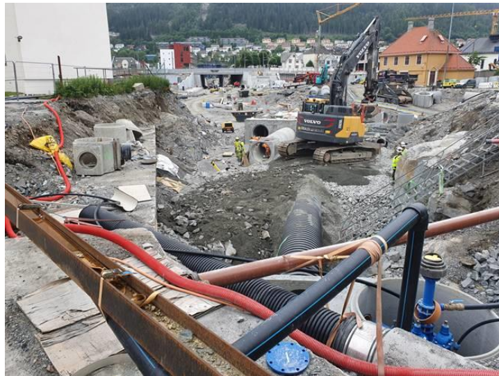
Fra bybaneentreprise D12 ved Kronstad/St: Halvardsvei. Eksisterende AF- og OV-kulvert (anleggsår 1924) blir skiftet ut med ny kulvert og rør. Bildet viser arbeid ved tilknytningspunkt til eksisterende anlegg i St. Halvardsvei.
