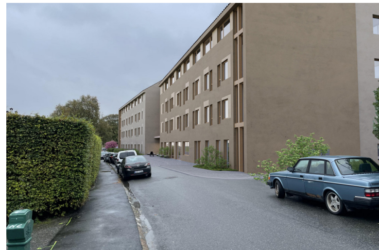
Fasade og kantsoner på nybygg langs Adolph Bergs vei.
