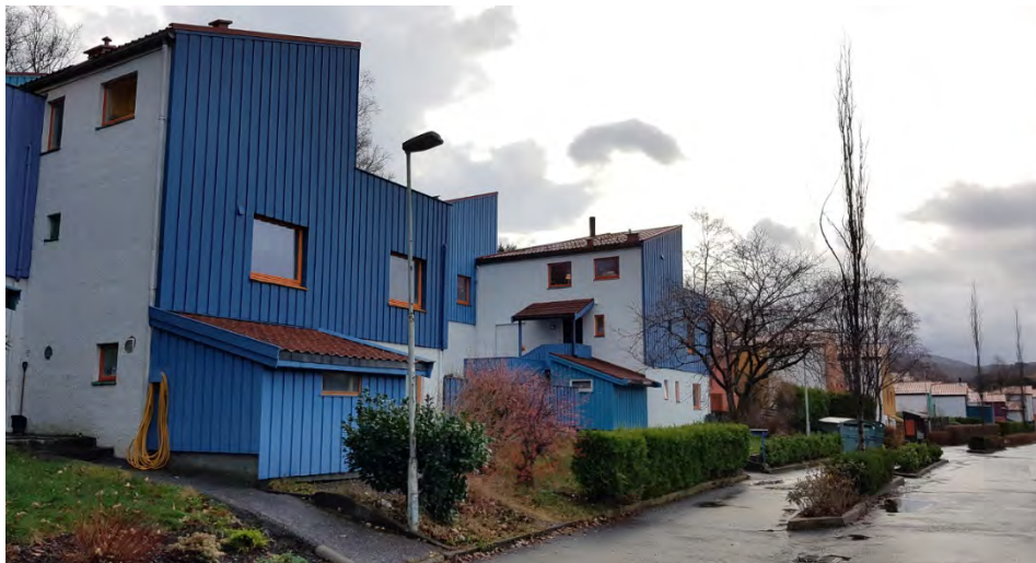
Figur 25: Selegrend er et spesielt byggeprosjekt fra midten av 1970-årene, som i dag er vernet med hensynssone for kulturmiljø i gjeldende KPA. (Foto: Byantikvaren 2018).
