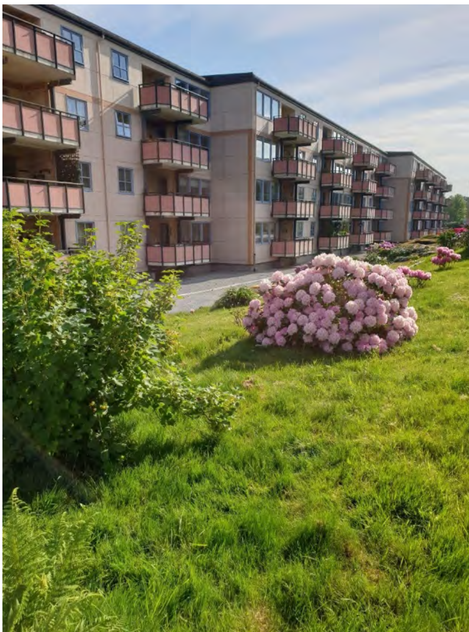
Figur 24: Prestestien borettslag med renoverte fasader (Foto: Byantikvaren 2021)
