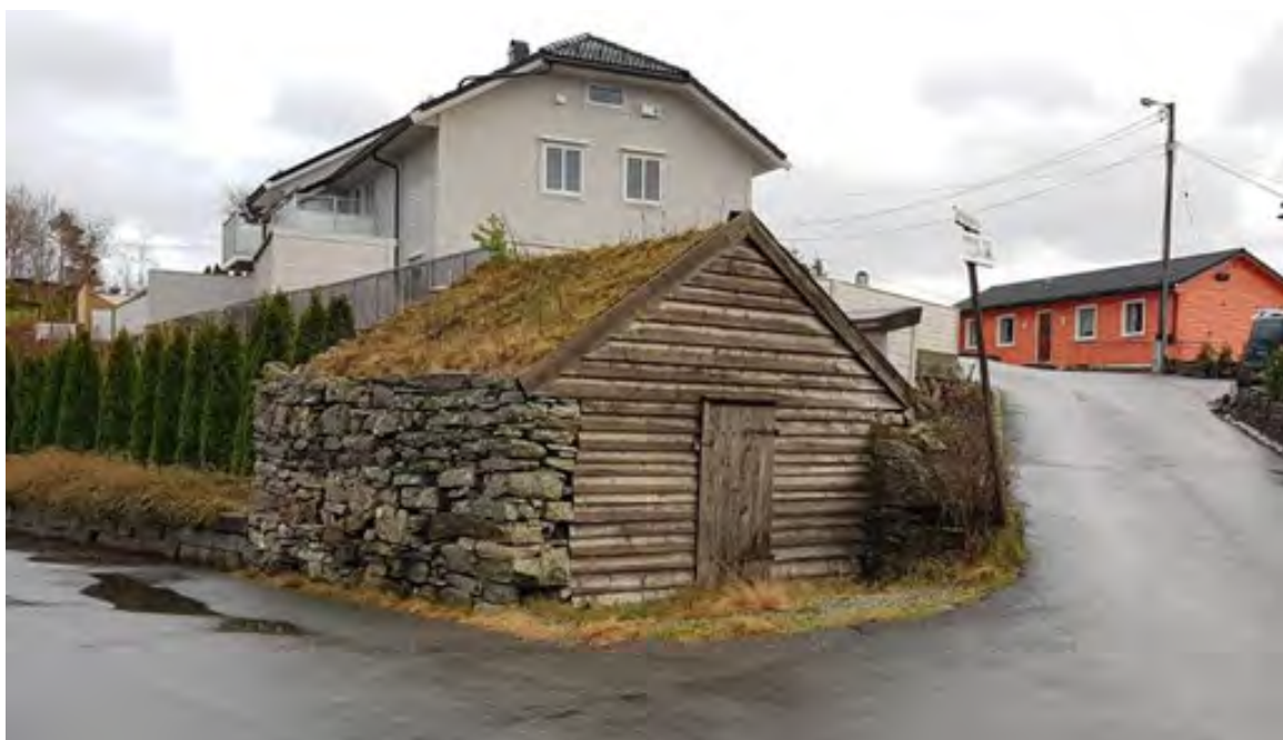
Figur 16: Steinhus på Ulset, gnr. 189 bnr. 412. Sannsynligvis et tidligere torvhus med sørgavl i tre., Huset står i dag midt i et veikryss, mellom et byggefelt og kjøpesenteret Horisont (Foto: Byantikvaren 2018).
