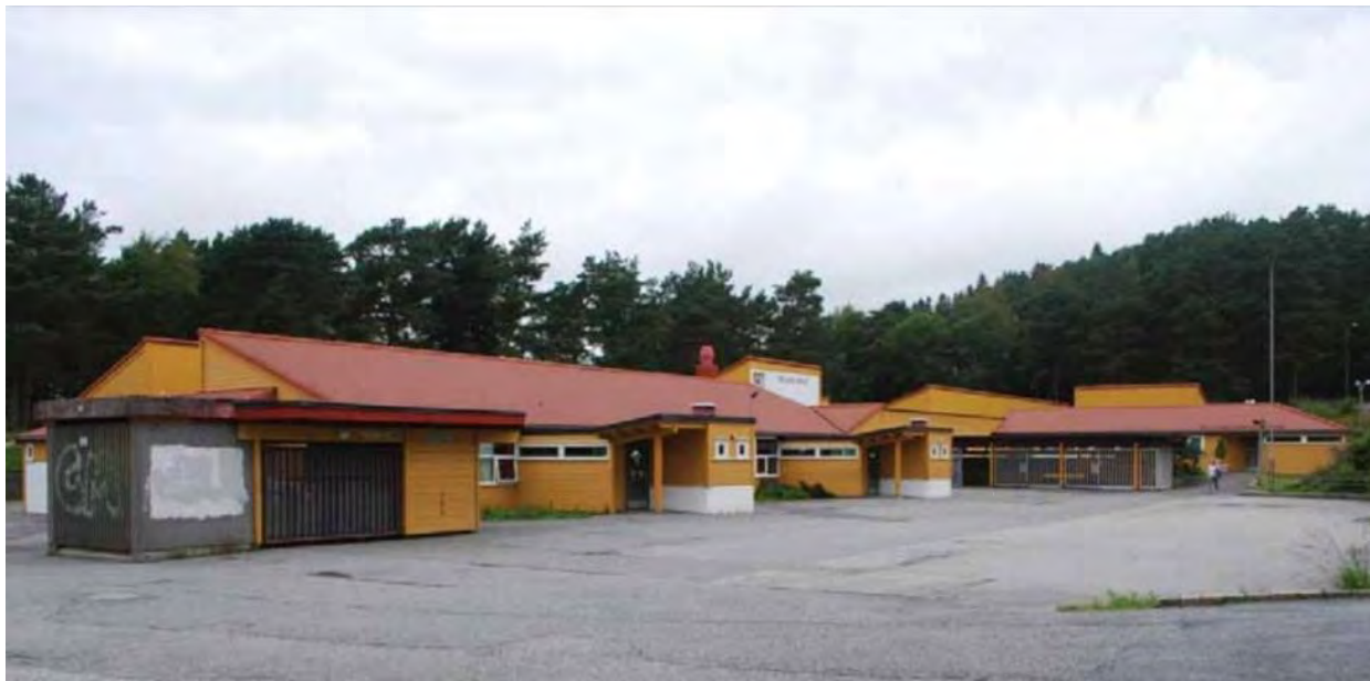
Figur 34: Rolland skole fra 1977 (Foto: Byantikvaren 2013)
