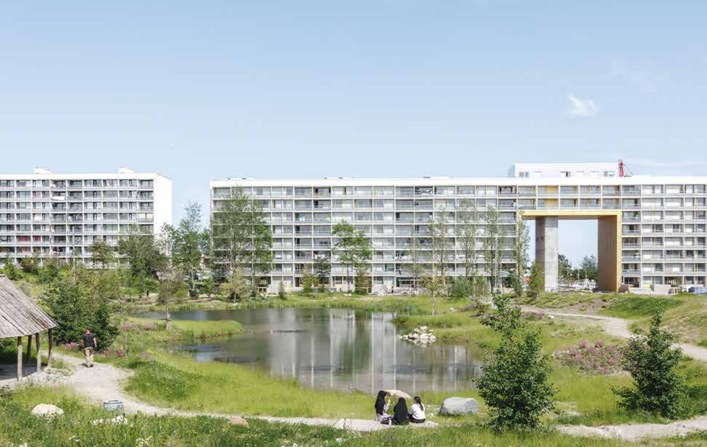
Gellerup New Nature Park, Aarhus Danmark. Brabrand Boligforening. Prosjekt av SLA, Cowi, Effekt, Gadeidræt, Social Action. Foto: Rasmus Hjortshøj - COAST Studio
