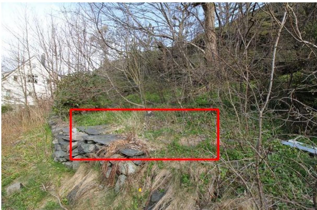
Figur 22. Tørrmur i naturstein, plattning av heller markert omtrentleg med raud firkant.
