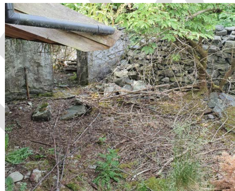
Figur 3-6: Rester fra tidligere løe/fjøs.
