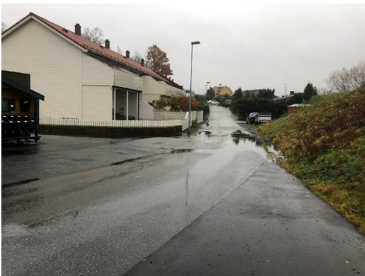
Figur 13: Nordgardsveien fra broen mot Harald Skjolds vei.
