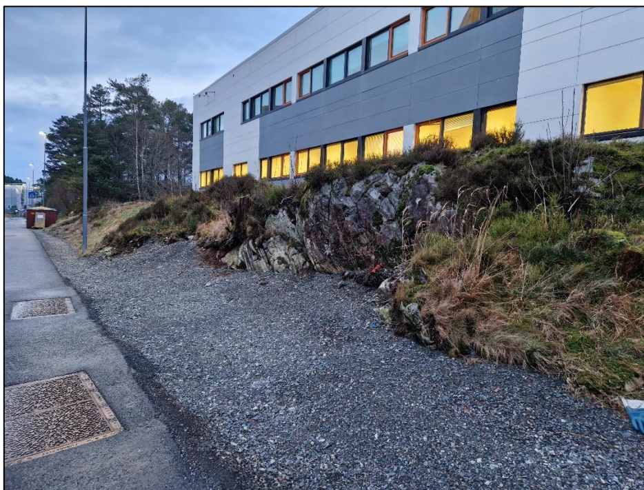
Figur 4. Bergskrent på vestsiden av planområdet. Foto: Multiconsult
