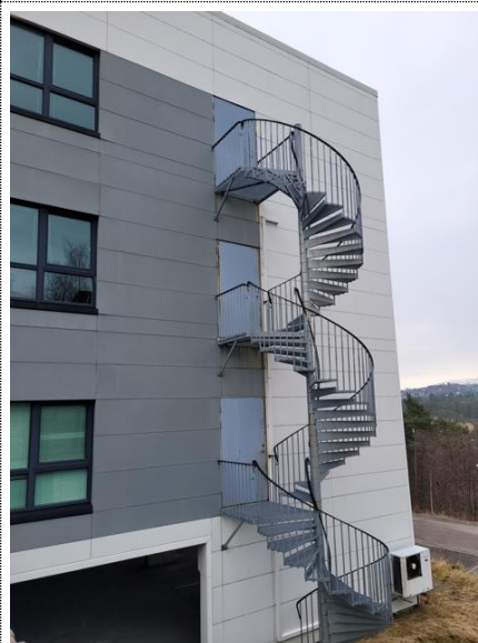
Bilde nr. 2.68 Rømningstrapp bygg H
