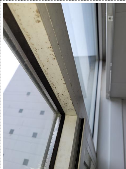
Bilde nr. 2.32 Glassfasade med muggvekst på alukarm
