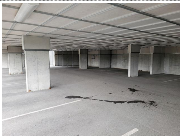
Bilde nr. 2.09 Parkeringskjeller
