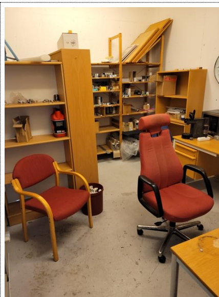
Bilde nr. 2.08 Kjellervegger i vaktmesterkontor
