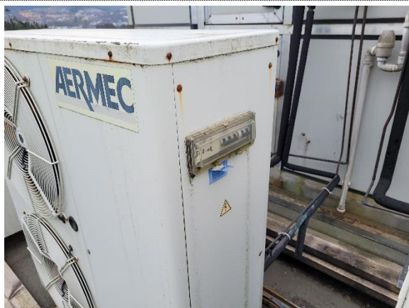
Bilde nr. 3.13 Luftbehandlingsanlegg blokk C og D
