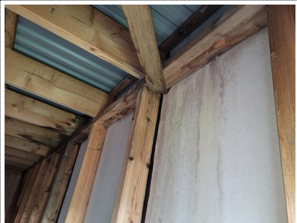
Bilde nr. 2.24 Synlig fuktpåvirkning på bindingsverk og takbjelker i teknisk rom på tak
