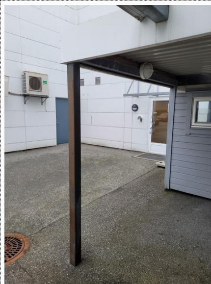
Bilde nr. 2.70 Skjermtak og tilhørende stålbering
