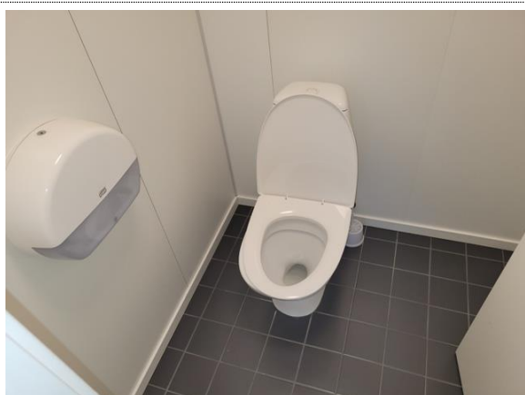
Bilde nr. 2.41 Innervegger toalett.
