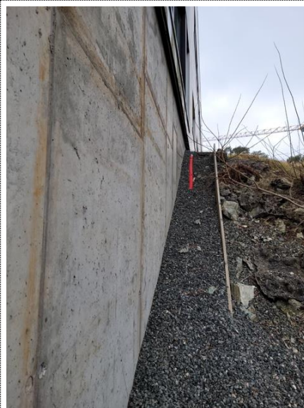
Bilde nr. 7.06 Skrånende terreng med tilkjørte masser
