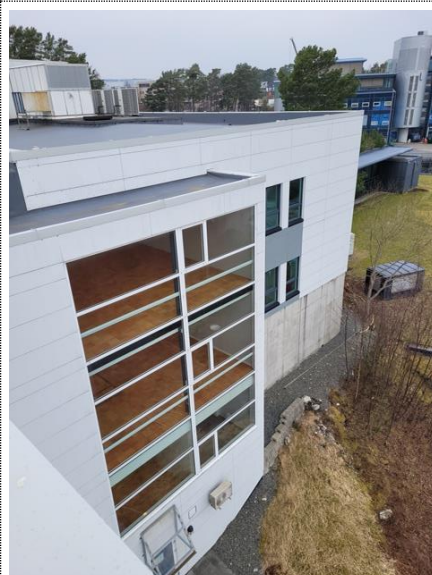
Bilde nr. 2.04 Fasade mot vest, nordlig del
