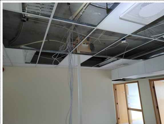
Bilde nr. 2.52 Systemhimling med fuktmerker i Bygg E
