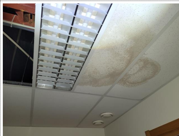
Bilde nr. 2.52 Systemhimling med fuktmerker i Bygg E
