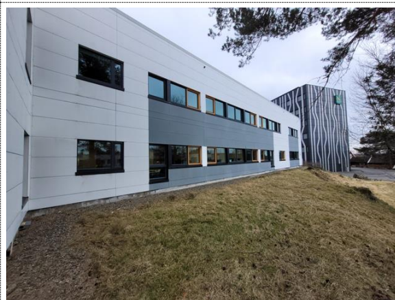
Bilde nr. 2.06 Fasade mot øst
