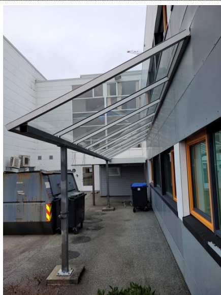
Bilde nr. 2.69 Skjermtak og tilhørende stålbering
