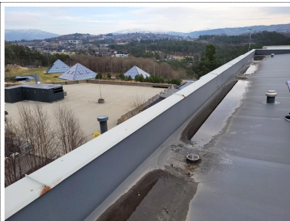
Bilde nr. 2.56 Yttertak bygg D
