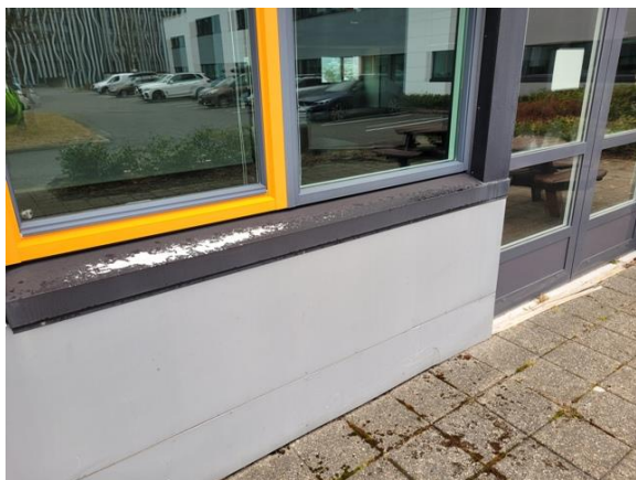
Bilde nr. 2.27 Vindu og vannbrett utvendig side
