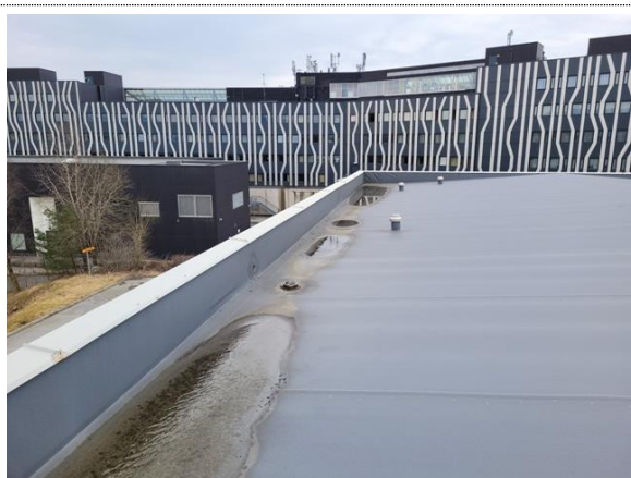
Bilde nr. 2.55 Yttertak bygg A
