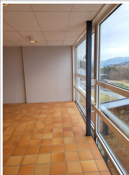
Bilde nr. 2.30 Glassfasade innvendig
