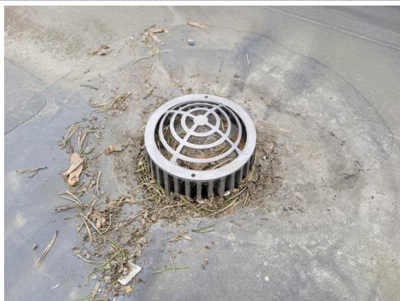
Bilde nr. 2.59 Innvendig taknedløp
