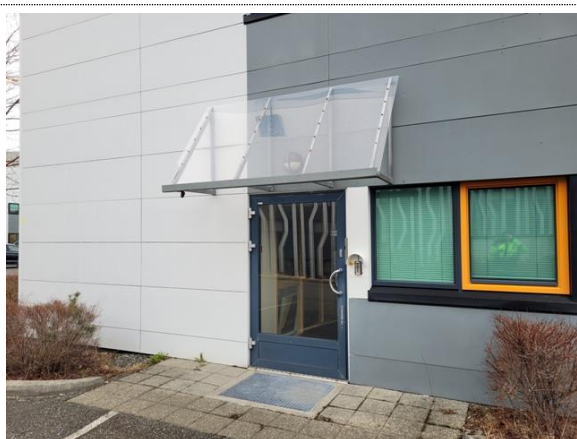
Bilde nr. 2.33 Inngangsdør bygg H
