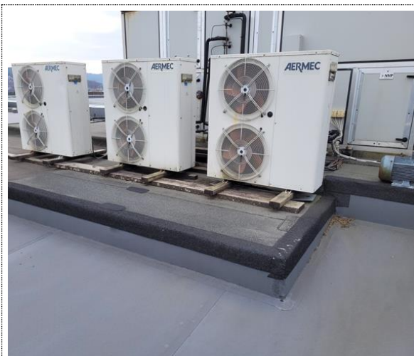
Bilde nr. 3.11 Luftbehandlingsanlegg blokk C og D
