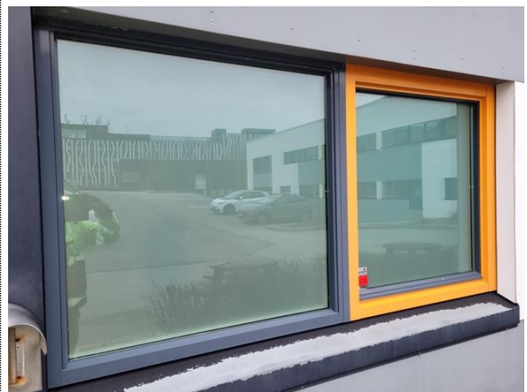
Bilde nr. 2.28 Vindu og vannbrett utvendig side
