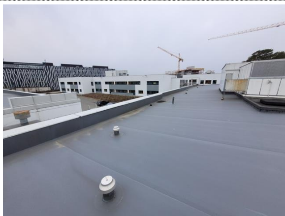
Bilde nr. 2.57 Yttertak bygg G
