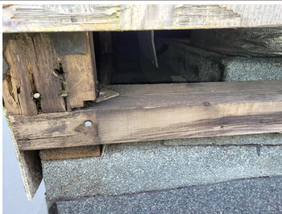
Bilde nr. 2.23 Råteskader i bindingsverk teknisk rom på tak
