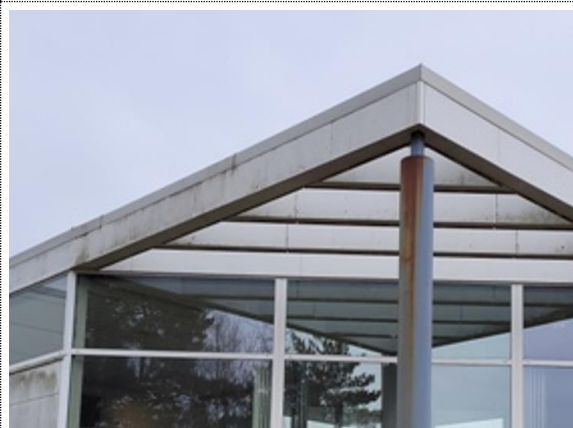
Bilde nr. 2.70 Skjermtak og tilhørende stålbering
