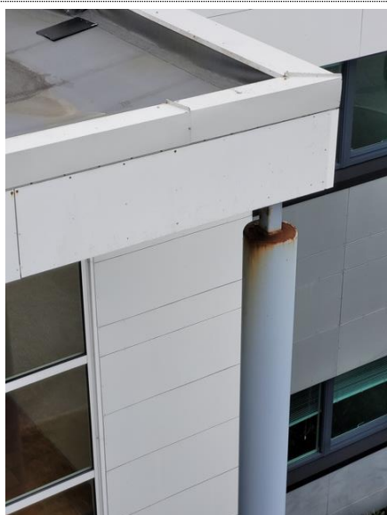
Bilde nr. 2.71 Stålstolpe for utkraget tak
