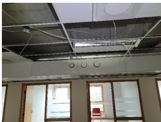
Bilde 1 Deler av synlig hulldekke over himling
