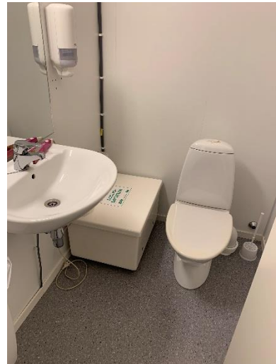
Bilde 12 Servervant og toalett antatt fra 1997/1999
