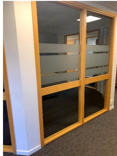
Bilde 8 Innvendige glassvegger, mot møterom
