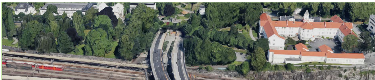
Figur 2: Portalmunninger Fløyfjelltunnelen på Nygårdstangen, hentet 15. september 2022 fra maps.google.no.
