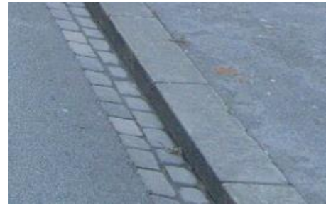
Figur 6-4: Prinsipp for gjennomgående kant på strekningen.
