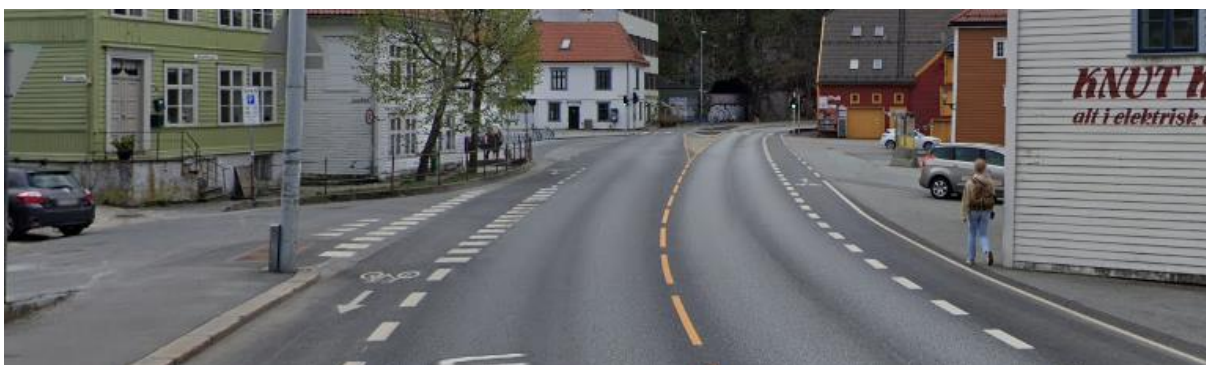
Figur 5-21: To eksempler på fortaussituasjonen på strekningen. Øverst på veg mot Skuteviken vestfra. Fortau på venstre side er opparbeidet fra Bontelabo, men smalner inn mot ingenting, og stopper i en betongkant. Nederst: Skuteviken nordfra. Det er ikke plass til fotgjengerne på utsiden av vegen, mens det ensidige fortauet på innsiden blir borte. Foto: Google Street View
