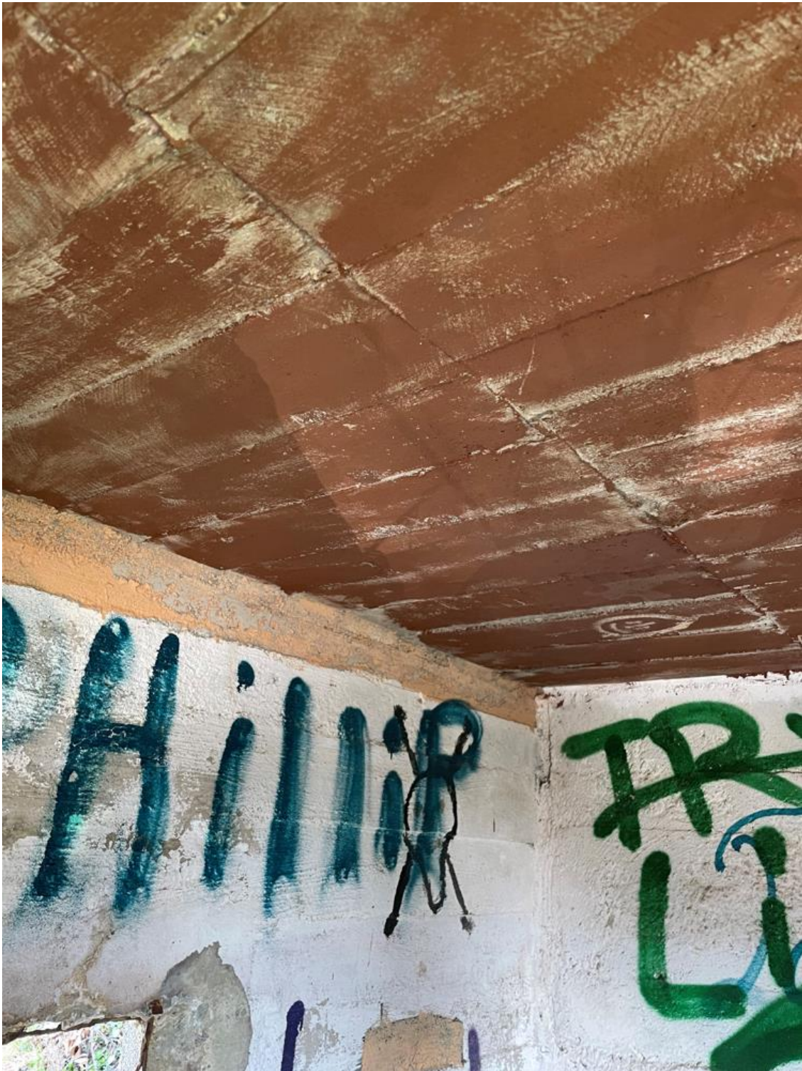
Figur 1-18: Bakvegg og vestvegg. Betongoverflater, delvis pusset/ malt overflater. Bordforskaling benyttet i betong i vegger og tak. Nyere tagging på overflater. Foto: Asplan Viak.
