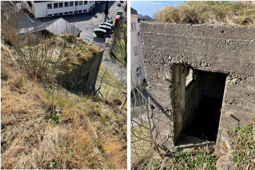
Figur 1-14: Nærforsvarsstillingen sett fra vest. Til venstre østfasaden med dørråpning/ inngang. Foto: Asplan Viak.
