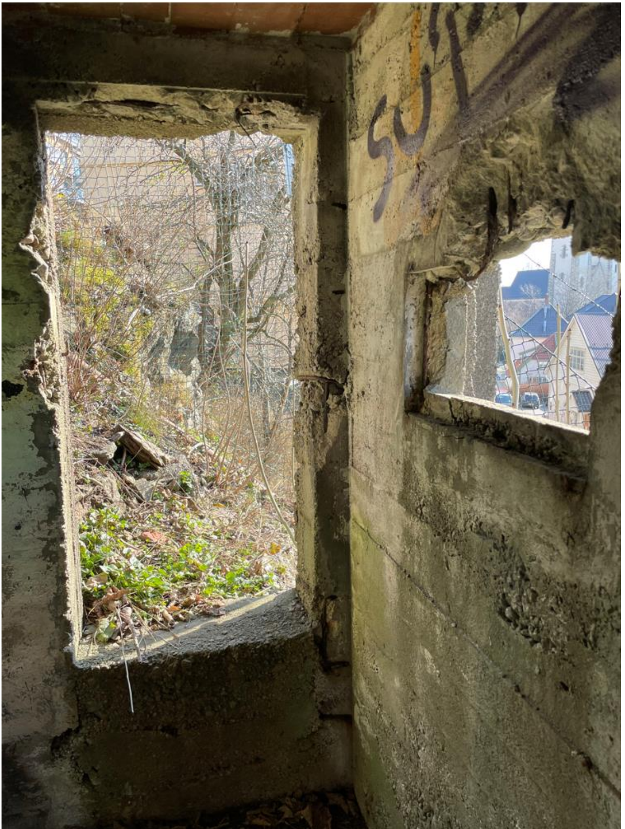
Figur 1-16: Inngang til venstre og skyteskår til høyre på bildet, sett innenfra. Foto: Asplan Viak.
