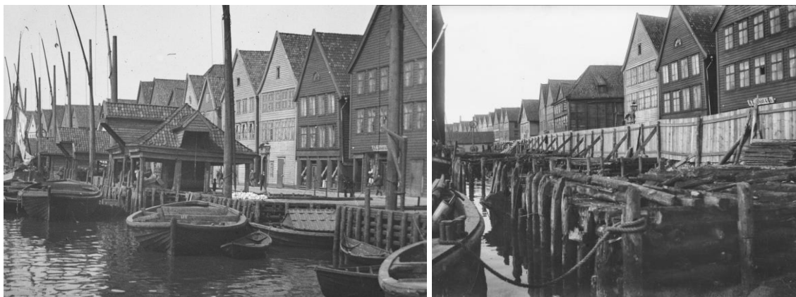
Figur 1-3 Søndre del av Bryggen, det senere Murbryggen. Bildet til venstre er fra slutten av 1800-tallet og viser vippebommer og skur på kaiene. Bildet til høyre er oppgitt å være fra 1899. Vippebommer og skur er fjernet, og demontering av kaiene pågår (Marcus, spesialsamlingene ved universitetsbiblioteket i Bergen, Lauritz Johan Bekker Larsen ubb-bros-00763, Gustav Emil Mohn ubb-gem-0201)
