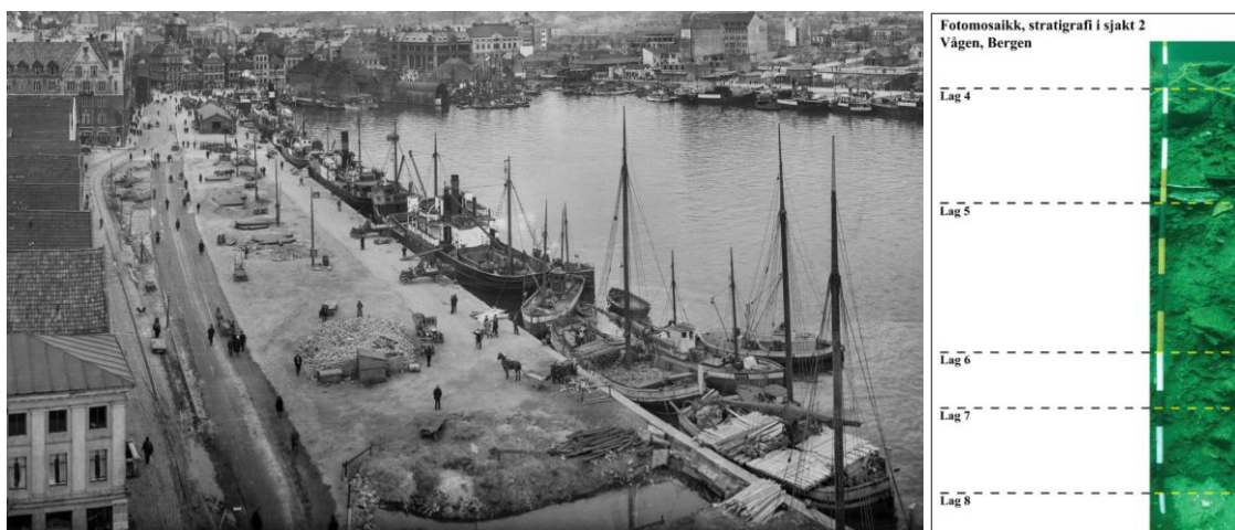
Figur 1-4 Bilde trolig fra tidlig 1920-tall. Den nye kaien utenfor Bryggen er nesten ferdig oppfylt. Et åpent parti gjenstår i nord, nederst i bildet. Til høyre en profil i en 160 cm dyp prøvesjakt i de marine kulturlagene utenfor Murbryggen (Marcus, spesialsamlingene ved universitetsbiblioteket i Bergen, Knud Knudsen & Co., ubb-kk-pan-0007. Bergens Sjøfartsmuseum)
