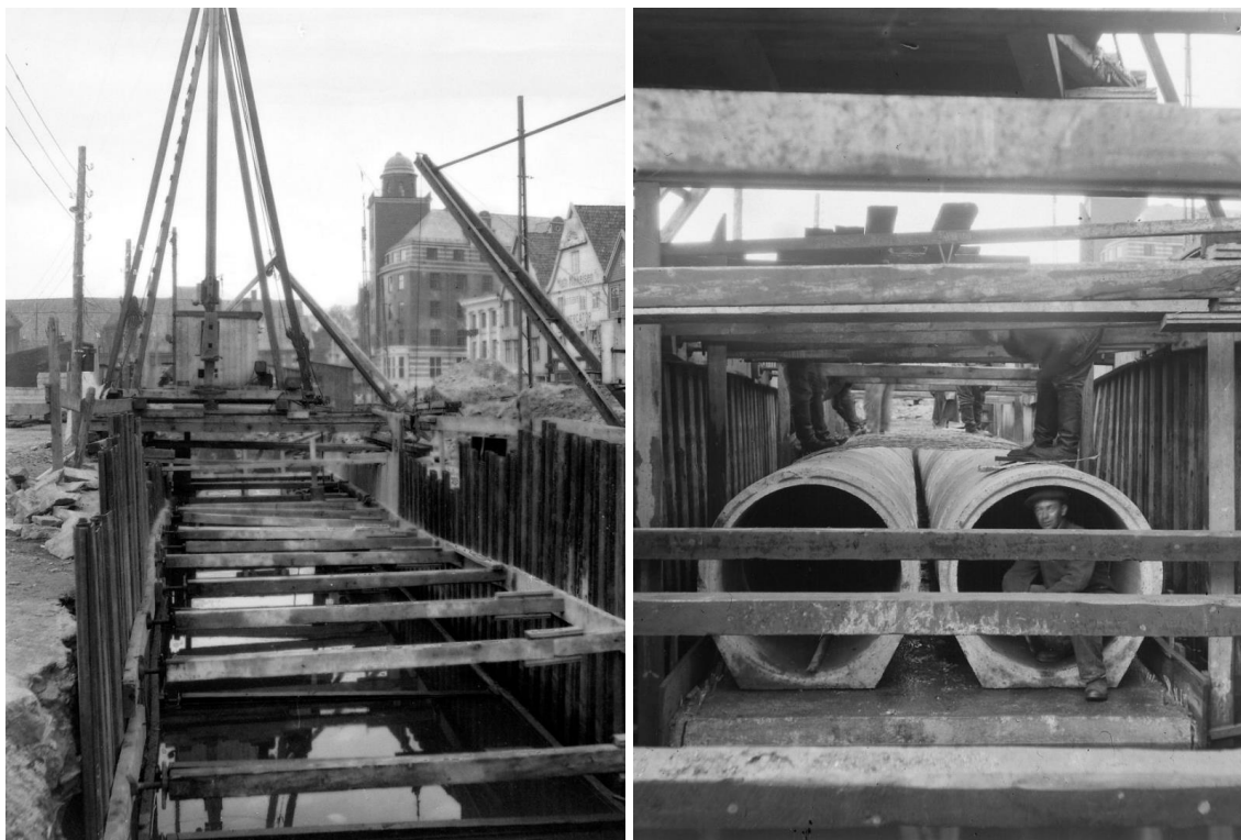
Figur 2-3 Fra etablering av dagens infrastruktur i den nye kaien langs Bryggen, rundt 1920. Dette er under dagens veibane. Byggingen har foregått i våt byggegrop. Her er det brukt en form for spunt på hver side av grøften, men den går trolig ikke dypt, og er avhengig av mye avstiving i gropen (Marcus, spesialsamlingene ved universitetsbiblioteket i Bergen, Ralph L. Wilson, ubb-bs-ok-13232 og -13277 av)
