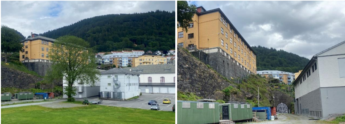
Figur 6-6 Til venstre den nordlige del av KM2 sett fra Koengen. Regimentsbygningen i overkant, Norrønahallen skimtes i bakkant til høyre. Bilde til venstre viser Jernbanetomten (Havnespor Nord) mellom Regimentsbygningen og BKK trafobygg
