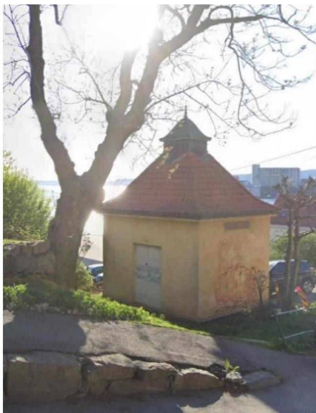
Figur 5-28: Trafokiosk Sandviksveien. Oppført i pusset mur. Arkitekt Einar Oscar Schou. (Google 2019).
