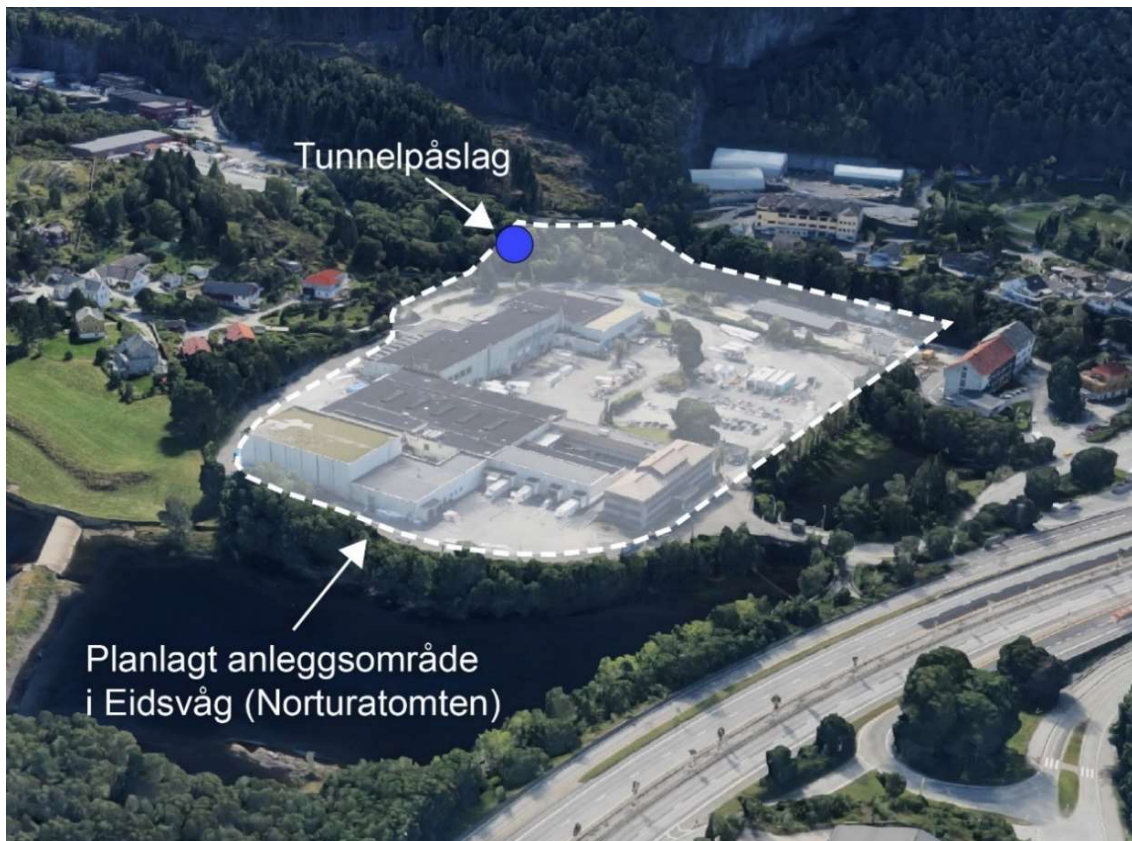
Figur 2-8: Arealet for framtidig rigg- og anleggsområde i Eidsvåg, vist på skjermdump fra jordklodevisningen til Google maps, sikretning sørover.
