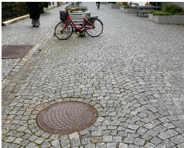
Figur 3-60 Brosteinsdekke i Welhavens gate og moderne gatemøbler, gir et godt inntrykk
