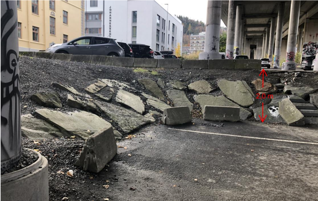
Figur 21: Bilde fra befaring.
