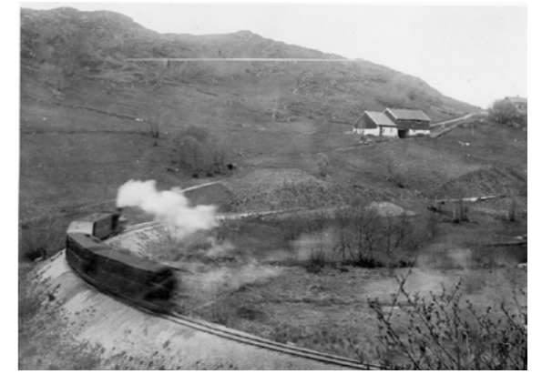
Osbanen ved Krohnhagen, ca. 1898 Foto: N. N. Sontum
