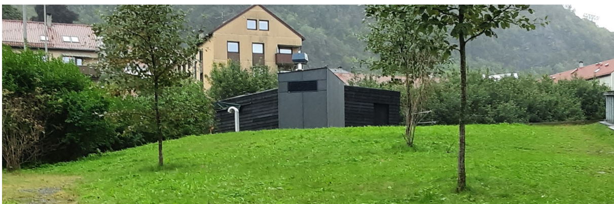
Bilde 3. lagerbygg propan
