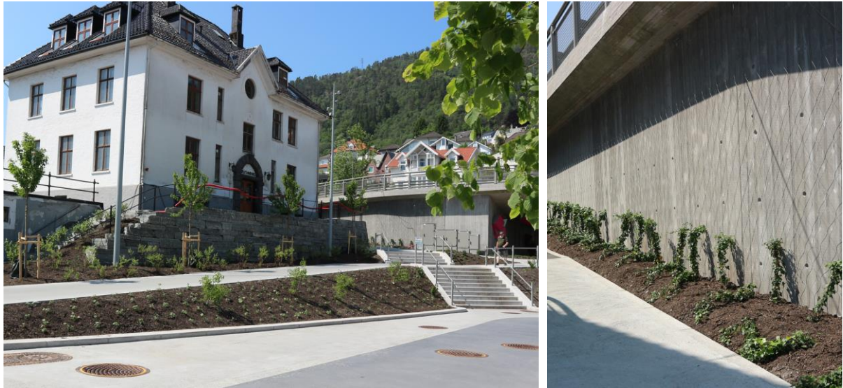
Figur 7: Etablerte grøntanlegg/bed ved bybanestopp, like nord for planområdet. T.h. er det lagt til rette for at eføy skal klatre og bre seg ut over mur-konstruksjon mot Fjøsangerveien. Foto: Opus, juni 2023.
