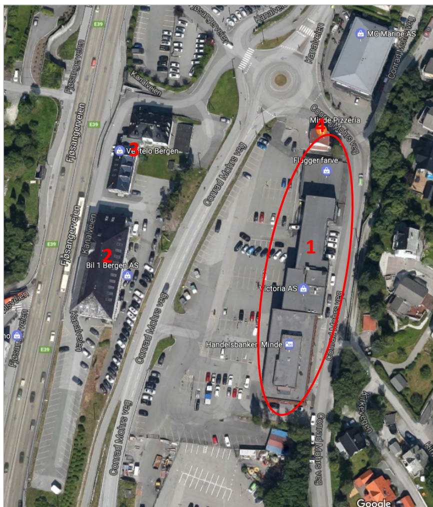
Figur 3: 1 Frydenbøs fire bygg langs C. Mohrs vei. 2 og 3: Frydenbøs bygg langs Fjøsangerveien. 4: Minde Pizzeria.
