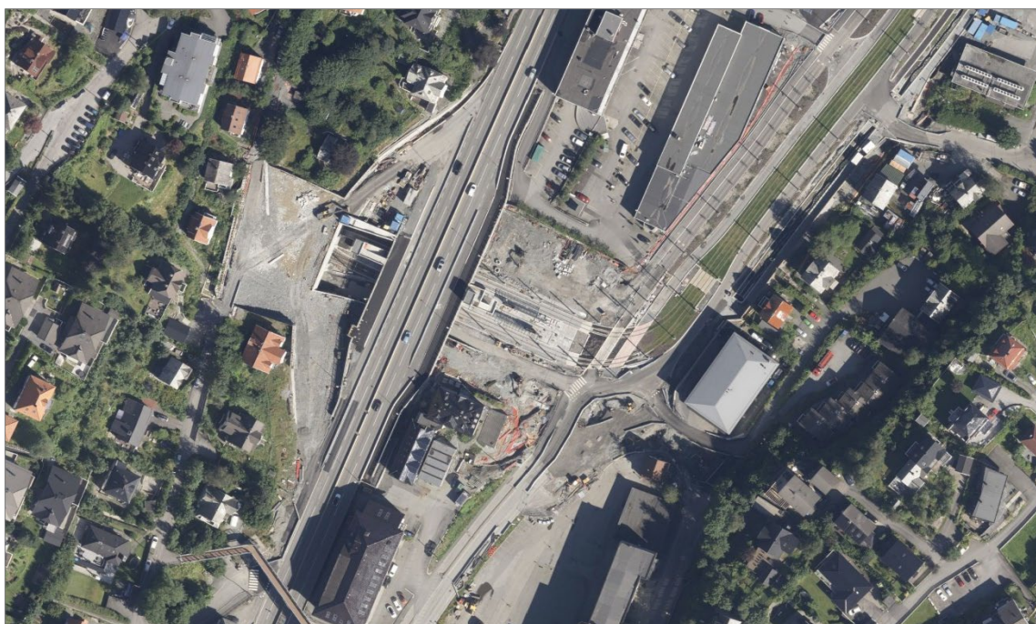
Figur 16: Dagens situasjon (2022) ved den nordlige delen av planområdet. Kanalveien 117 a og b (eksisterende verneverdige bygg, som skal bevares, er synlige i midten nederst på bildet. Kilde: Norge i bilder.
