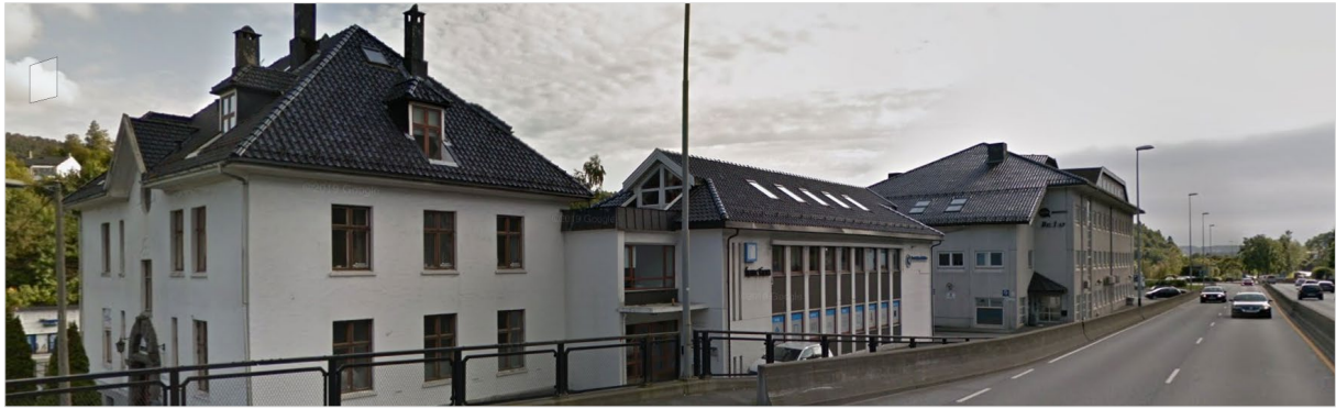
Figur 4. Frydenbø sine bygg langs Fjøsangerveien. De to til venstre skal bevares. Kilde: Google maps
