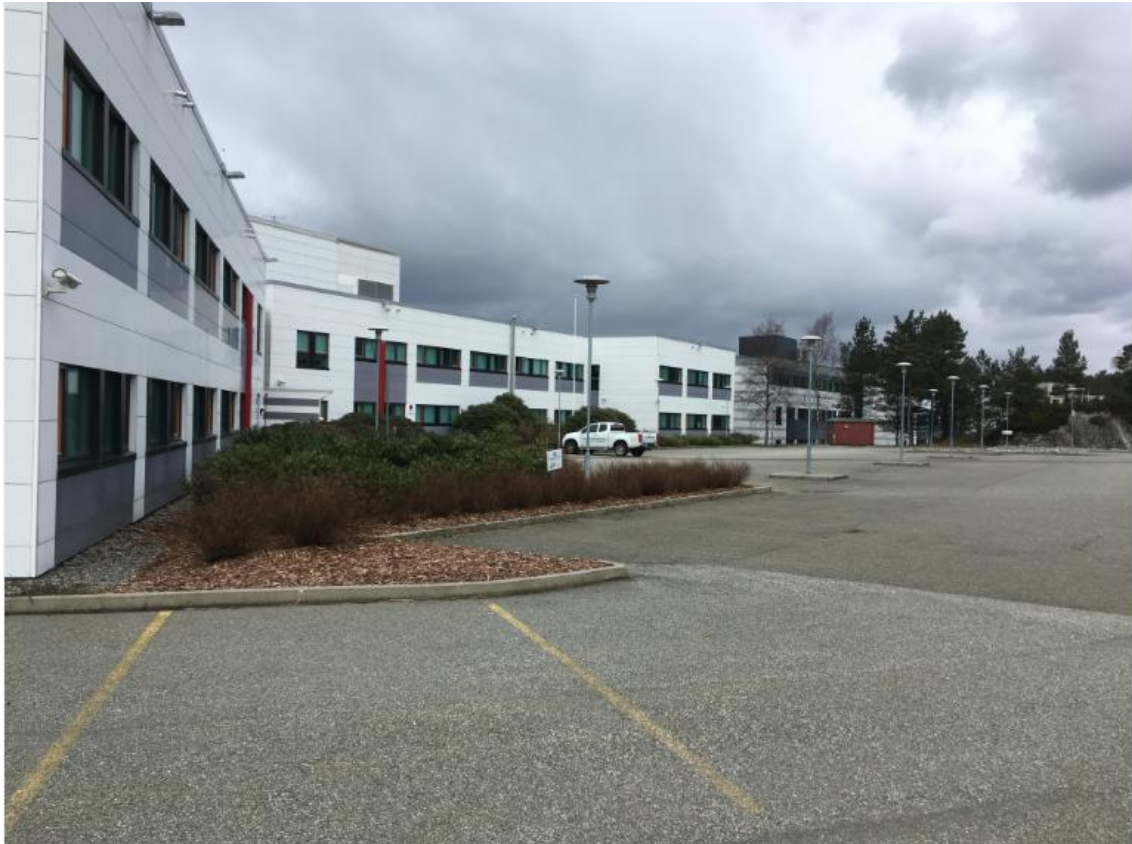
Figur 5. Bilde tatt mot nord, på parkeringsplassen, fra sørlig del av bygget. Det røde trafobygget ligger rett nord for tomtegrensen og ligger på naboeiendommen (Sandslåsen 57).
