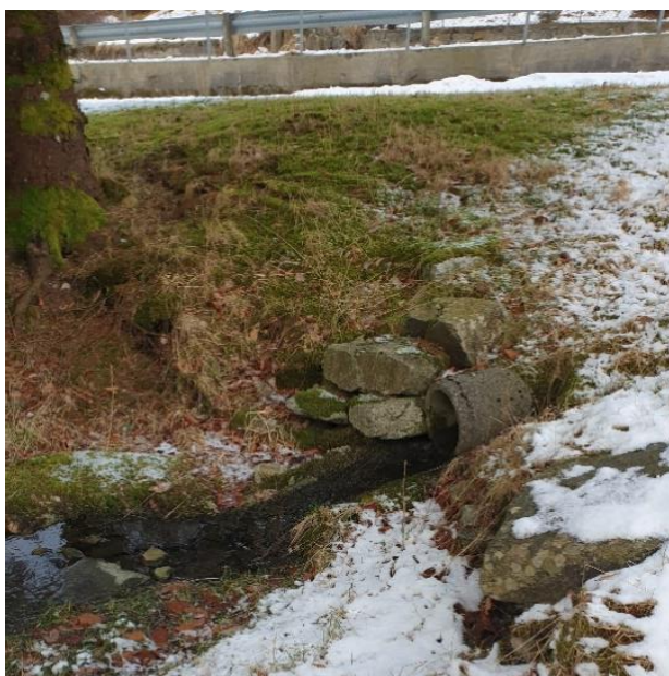
Figur 1 Utløp fra stikkrenne under Totlandsvegen
