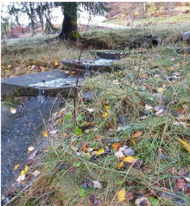
Figur 2 Murte trinn i eksisterende bekk
