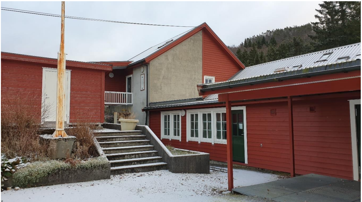
Ved inngangspartiet – sett mot nord.
