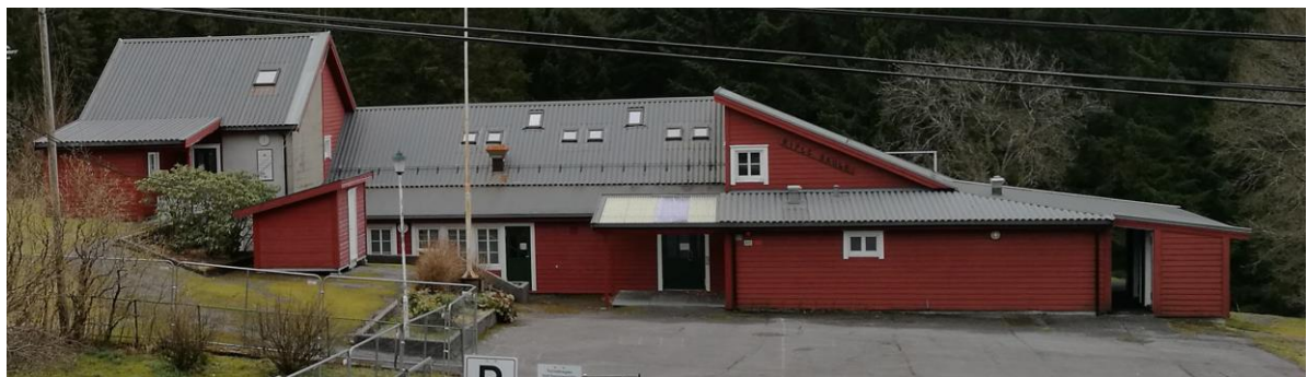
Fasade vest – hovedfasade mot skoleplassen.
