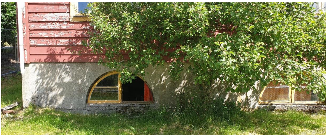
Kjellervindu fasade sør
