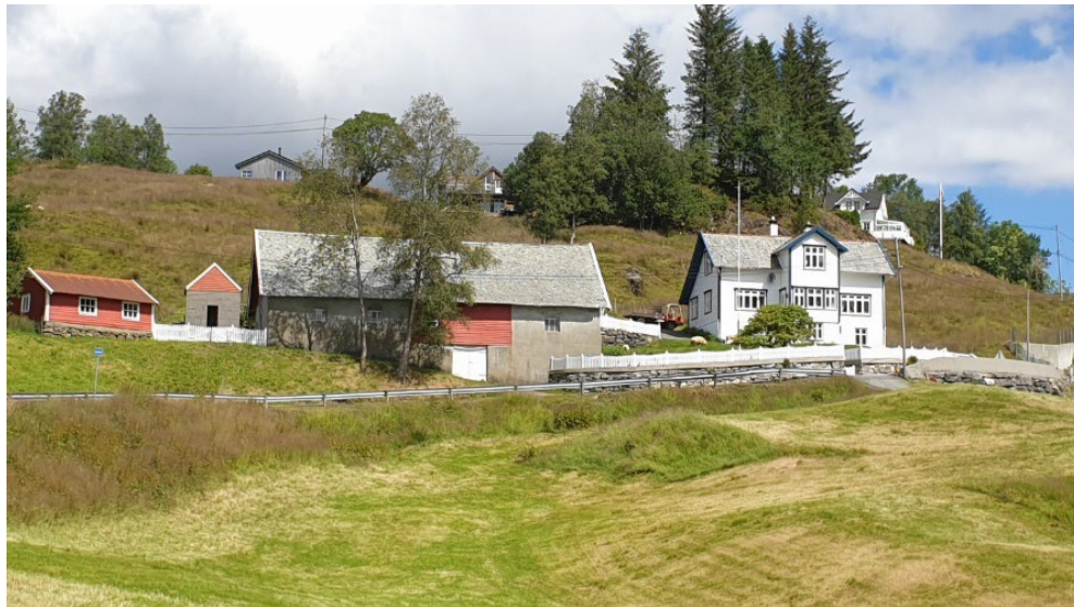
Gårdsbygninger på bruk nr. 2, Totlandsvegen 448. Våningshuset er oppført i sveitserstil
