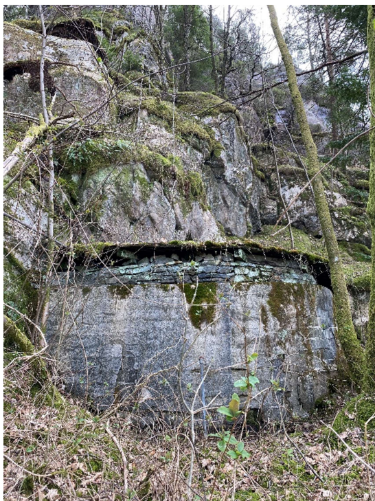
Figur 20: En av to gamle, vannfylte høydebassenger. Her ved ca. lokasjon 836.
