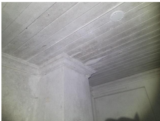
Bilde 8: Soppvekst på alle overflater
