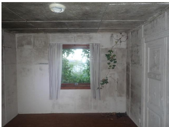
Bilde 7: Soppvekst på alle overflater
