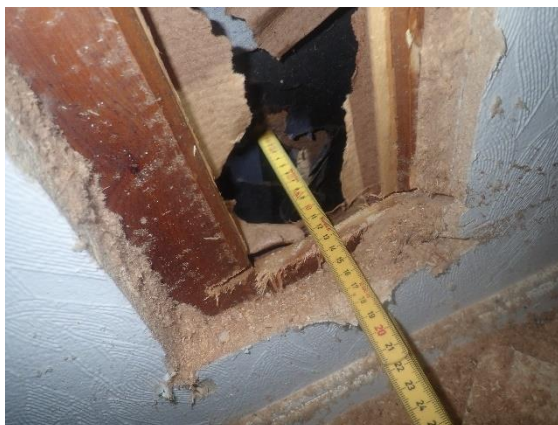
Bilde 4: Veggkonstruksjonen i 2. etasje
