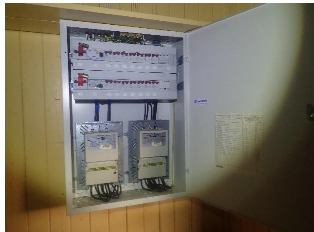
Bilde 14: Sikringskap i gang
