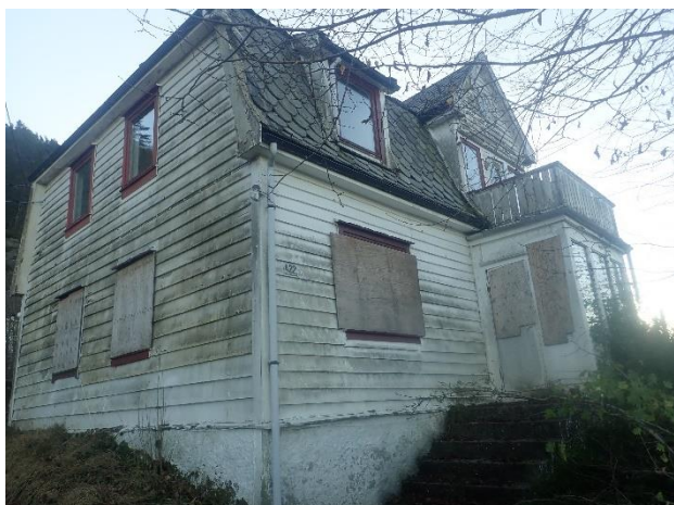
Bilde 5: Maling på trekledning og på mur inneholder metaller over grensen for farlig avfall
