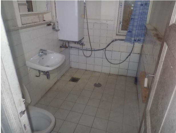
Bilde 1: Flis og avrettingsmasse på bad inneholder ikke asbest
