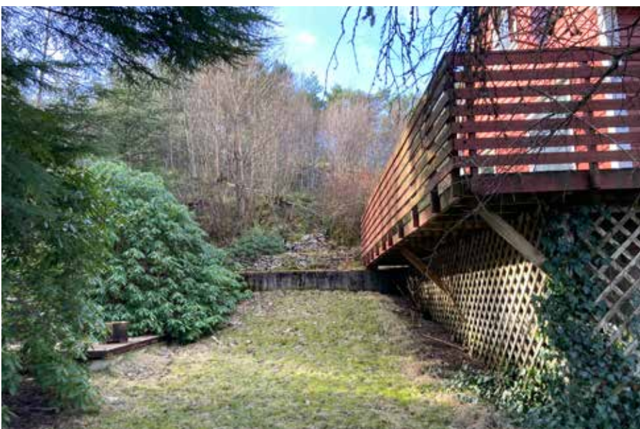
Detalj veranda og hage. Legg merke til murar midt i bildet.
