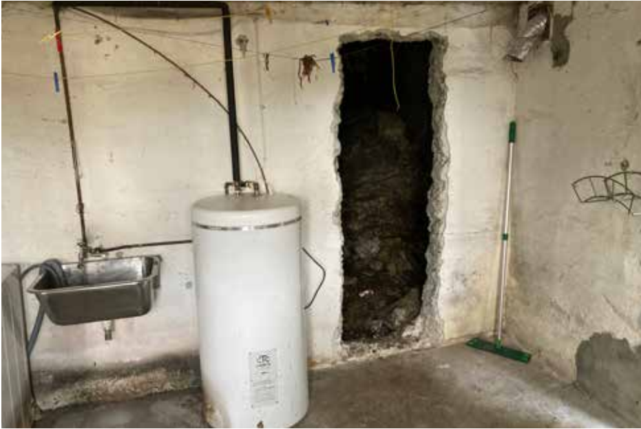
Rom 1. Opning i mur inn til krypkjellar.
