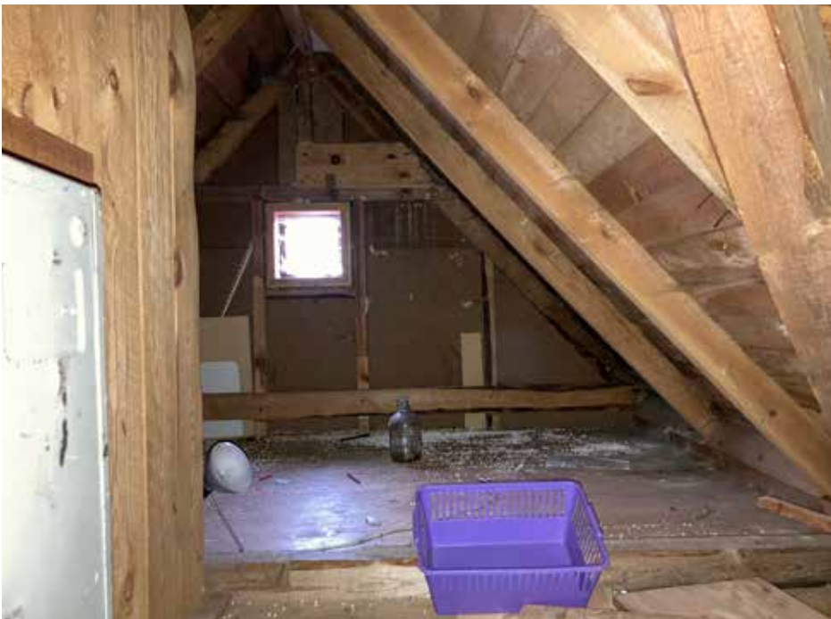
Loft på tilbygg/vindfang.
