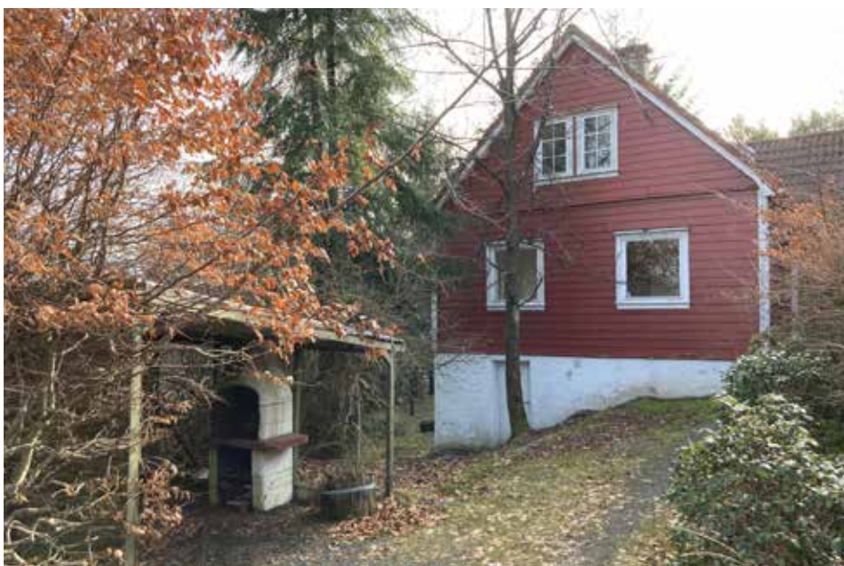
Bustadhus, fasade mot nord. Alle vindauge er skifta ut etter at huset blei bygd i 1954.
