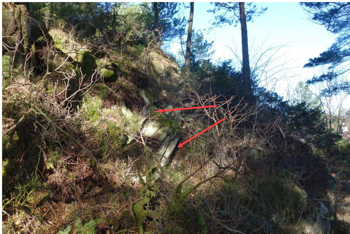
Figur 11. Sprekkesett 2 står steilt inn mot nordvest sør i tomteområdet, vist i rød markering
