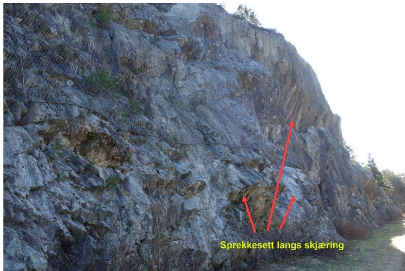
Figur 10. Bergskjæring øst for Ytrebygdsveien sett mot sør. Skjæringens kontur følger de dominerende sprekkesettene i stor grad.
