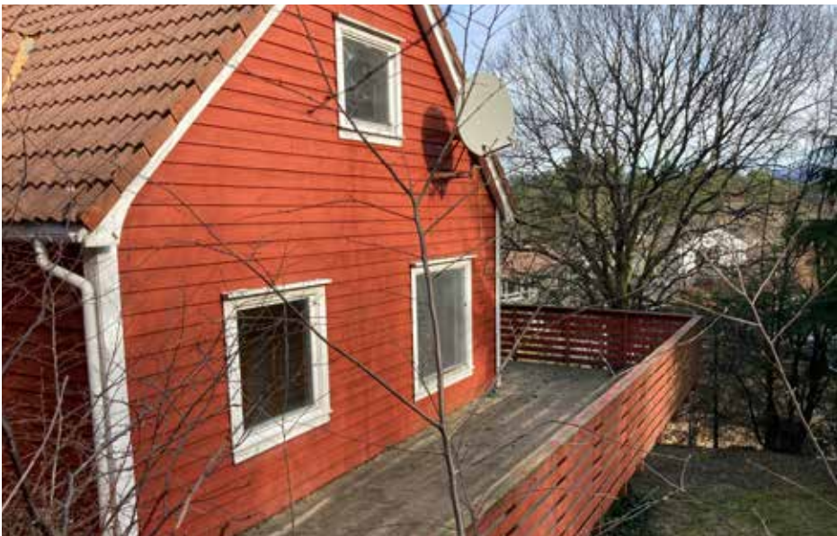
Bustadhus, fasade mot sør med veranda bygd på i seinare tid.
