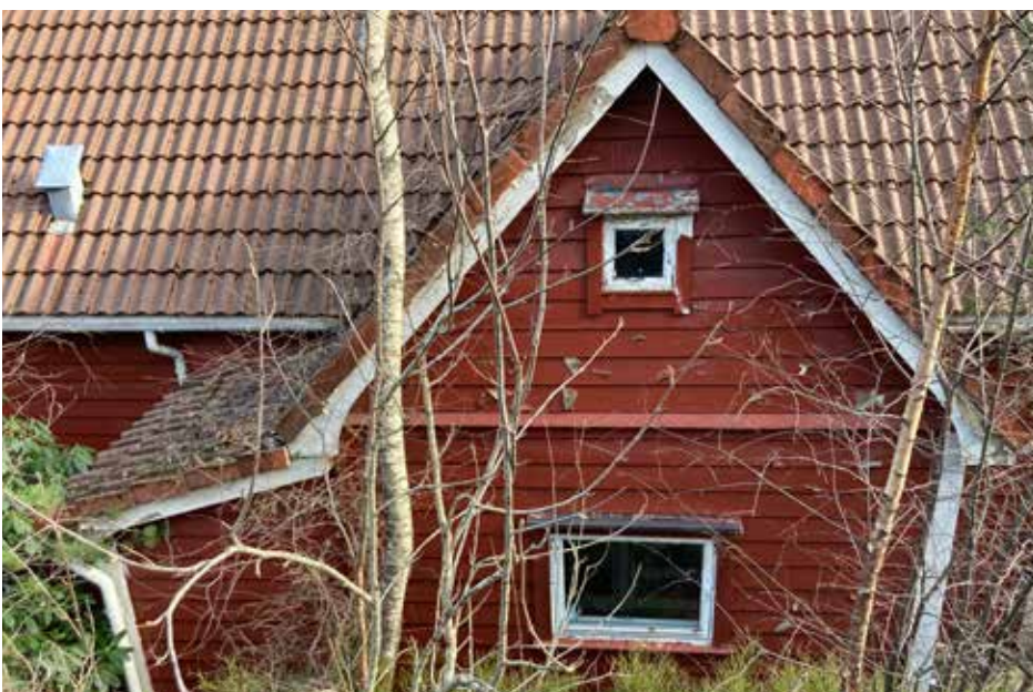
Bustadhus, fasade mot vest med tilbygget. Vindauga i loftsdelen av tilbygget er truleg det eneste originale som er igjen i dag.
