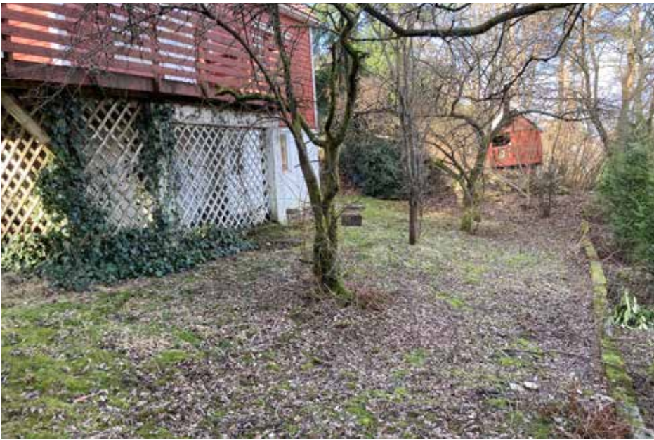
Detalj veranda og hage mot aust.
