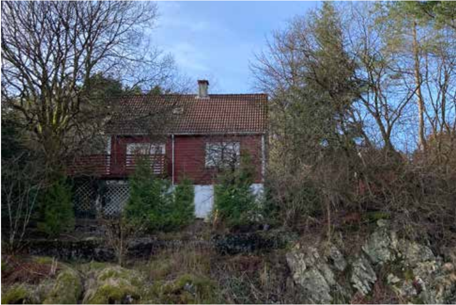
Bustadhus, fasade mot aust, ned mot Ytrebygdsvegen.
