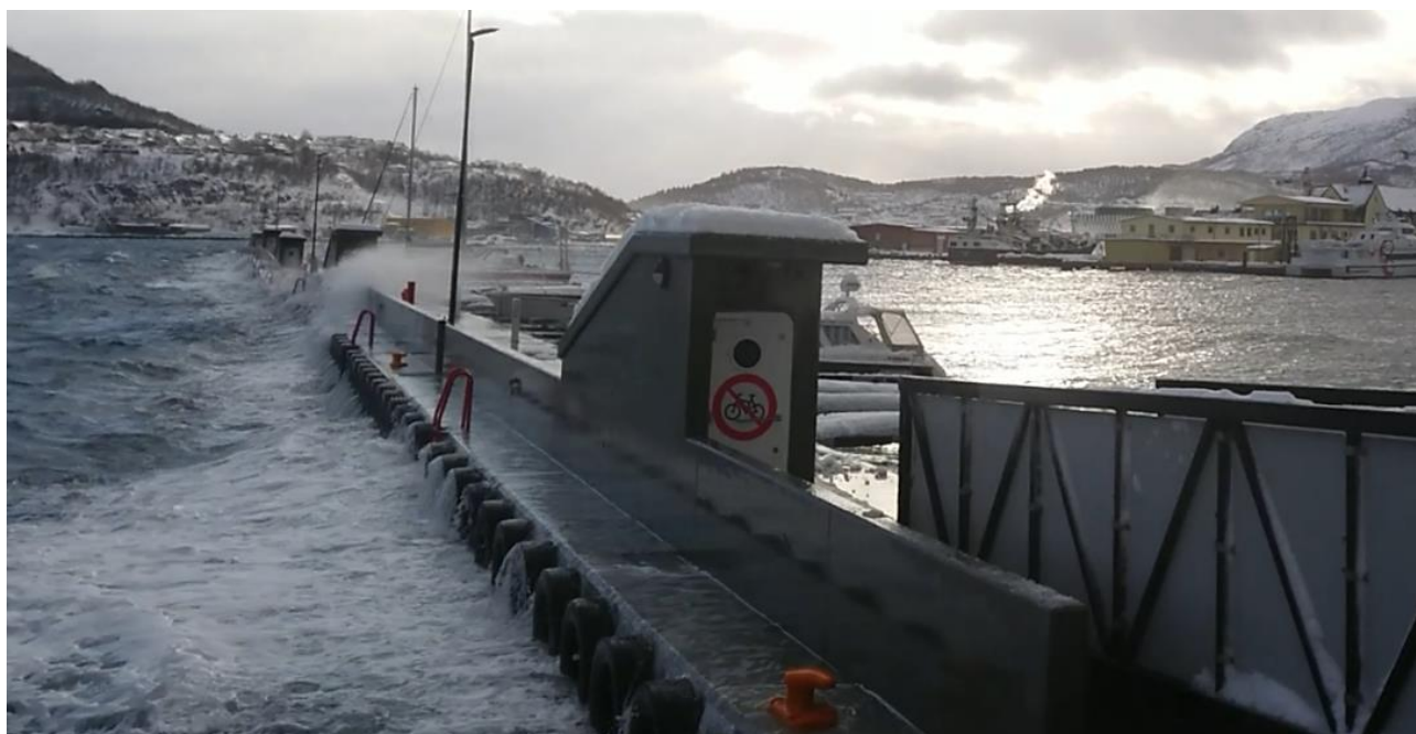
Figur 6 Flytemolo (Marina Solutions) i aksjon i Harstad. Det finnes fortsatt bølger på baksiden, men de er sterkt dempet og gir færre problemer for mindre båter og personell. Nedgang til innvendige rom er synlig. Sprutskjerm (ca 0.9 m høy) er en opsjon, men anbefales på alle anlegg.
