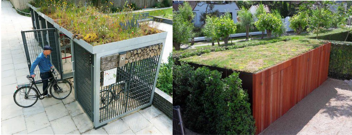
Figur 16-1: Eksempler på utvendig overdekket sykkelparkering.
