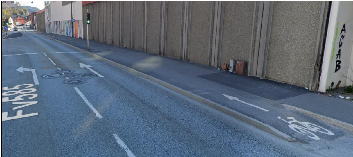
Figur 5-6 Sjøgaten sett mot sentrum. Overgang fra sykkelfelt til fortau.
