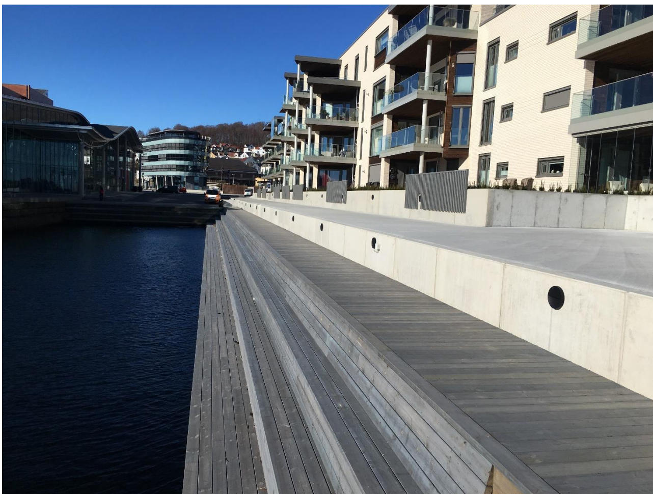
Figur 23 Larvik/Sanden: avtrapping ned mot sjøen. Trekonstruksjonene blir oversvømt ved ekstrem flo, mens det vil komme noe vann inn på gangveien. Byggene og leilighetene er tilnærmet helt beskyttet mot vann.
