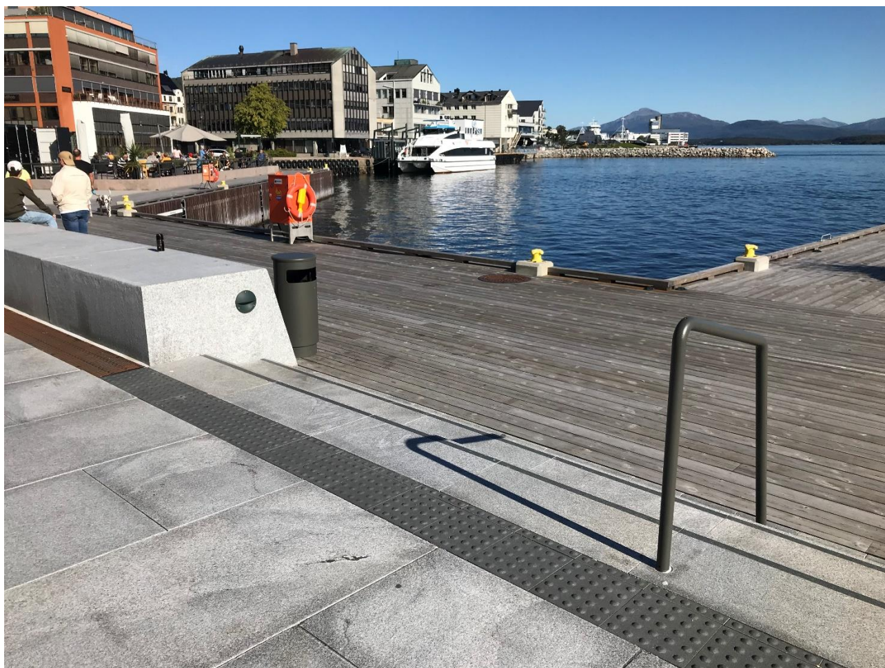
Figur 20 Trappekonstruksjon mellom granittblokkene for ferdsel mellom nivåene. Det er beregnet at den vannmengden som slipper inn mellom blokkene er liten nok til at totalbelastningen på gangveien er akseptabel.
