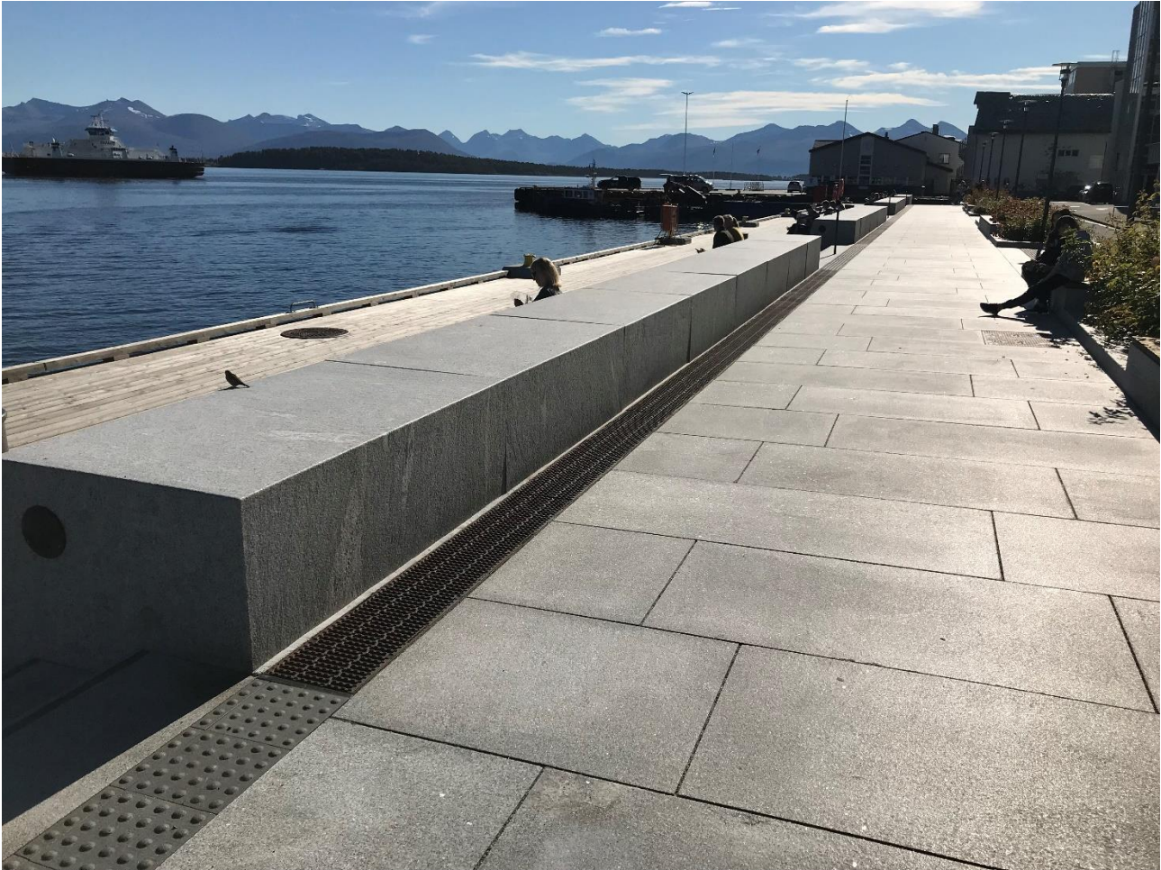
Figur 19 Sjøfronten i Molde: granittblokker som skiller den flomutsatte delen til venstre fra gangveien til høyre. Dreneringsrenner ved granittblokkene hindre magasinering av vann på gangveien.
