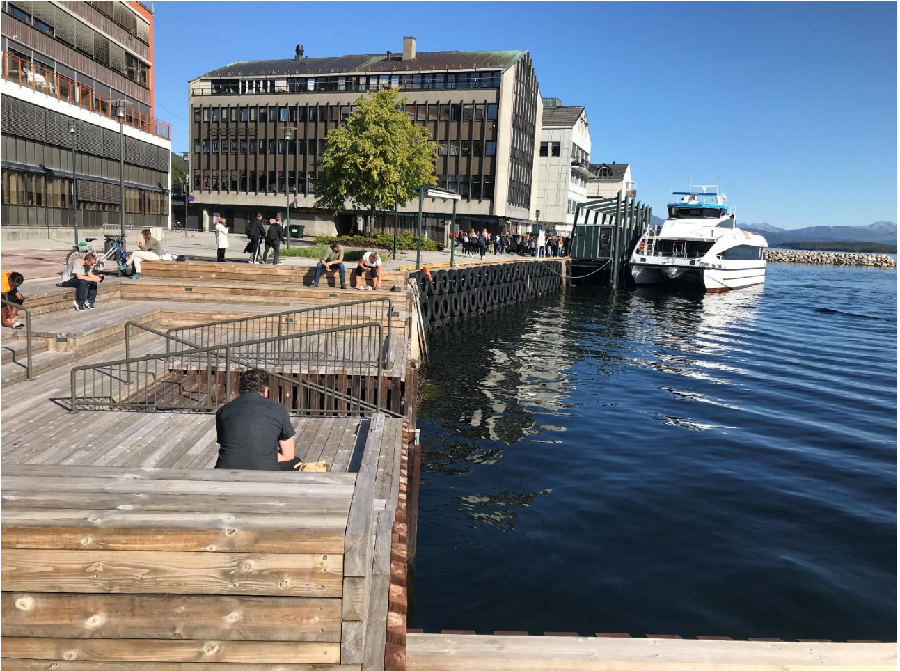
Figur 18 Fra Sjøfronten i Molde: nedsenket publikumsanlegg som ikke er flomsikkert selv ved moderate stormflo-nivå
