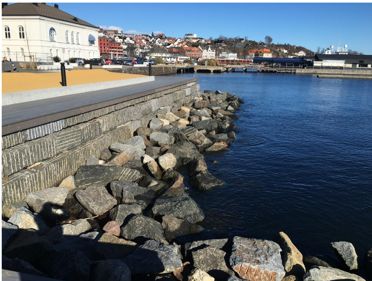
Figur 21 Larvik/Sanden: grove steinblokker demper bølgene og reduserer oppskyllingen på gangveien
