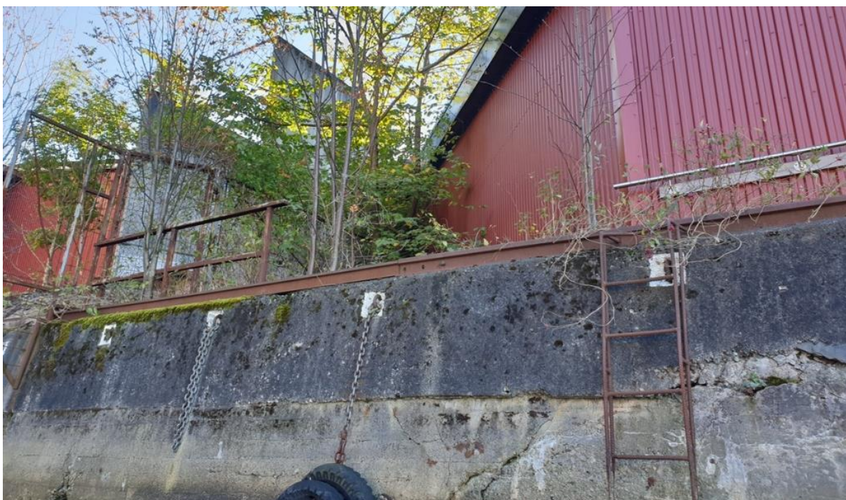
Figur 4. Bratte bryggekanter og småvokst trevegetasjon uten nevneverdig verdi. Foto: Odin Kirkemoen 14.10.2020.
