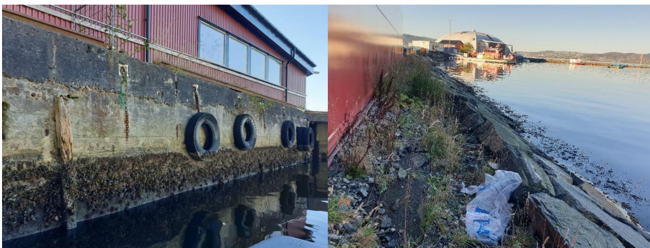
Figur 7. Delområde 1. T.v.: Loddrette kaikanten stupte rett i sjøen og ned til 3-5 m dyp. Bildet er fra Delområde 1, østre del. T.h.: skrånende steinfylling ut i sjøen på vestlig del av delområdet. Foto: Odin Kirkemoen 14.10.2020.
