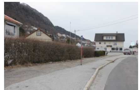
Figur 7. Manglende asfaltering og helhetstenkning ved busslomme ved Kjøkkelvikvegen. Området bak fortau er tilkomst veg for boliger.
