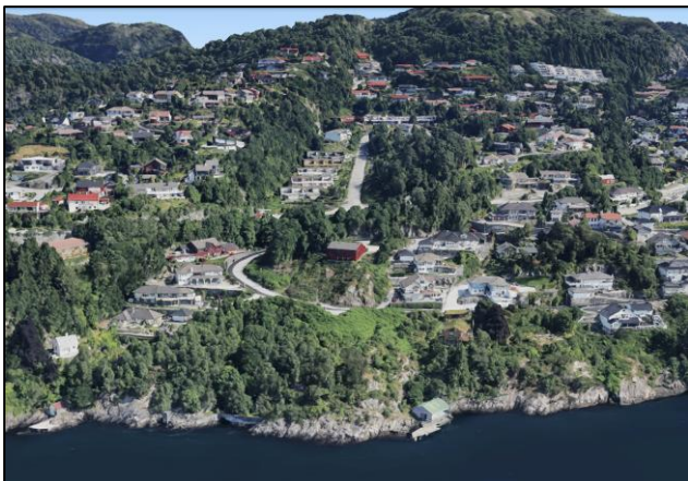
Figur 3.1.2.2 – Skråfoto av tomten før Bergen vann sitt arbeid med ny ledningstrase. Kilde: Google Earth
