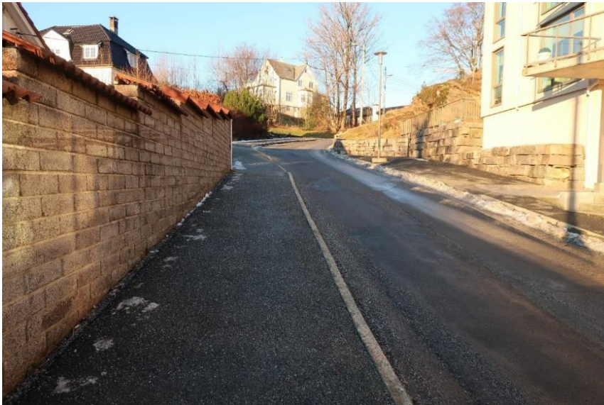
Figur 4: Fortau på vestsiden av Jacob Kjødes veg (Sweco, befarings 17.01.19)
