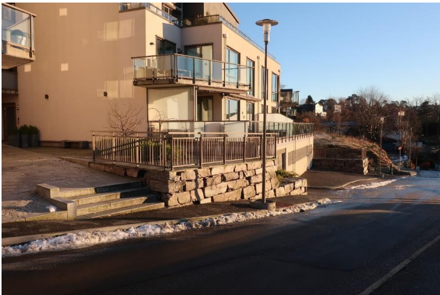
Figur 5: Fortau på østsiden av Jacob Kjødes veg (Sweco, befarings 17.01.19)
