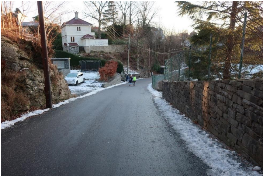
Figur 6: Ingen tilbud for gående- og syklende langs Jacob Kjødes veg sør for krysset (Sweco, befaring 17.01.19)
